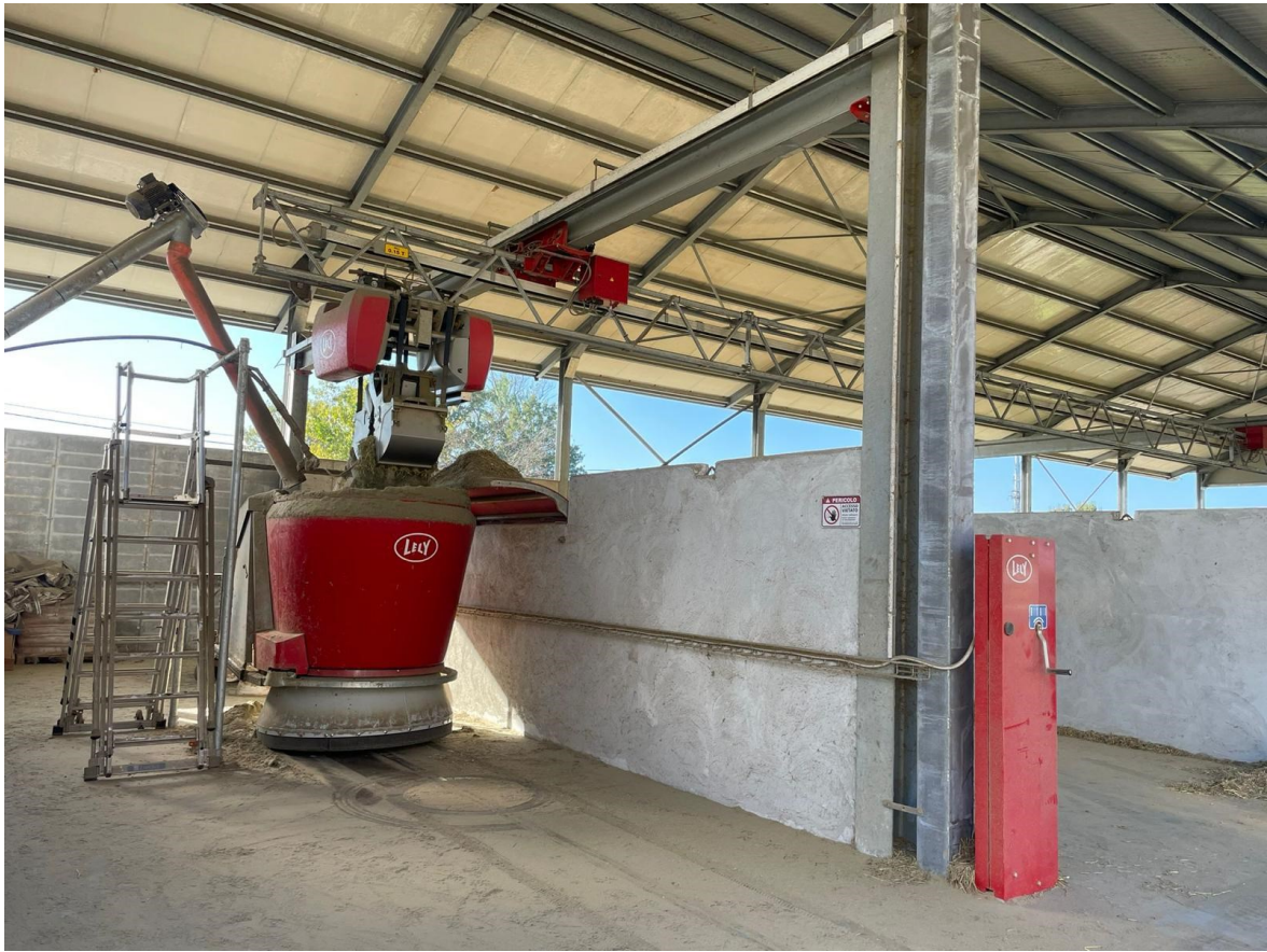
Figura 13: Caricamento alimenti nel sistema distributore presso l'azienda Benassi
