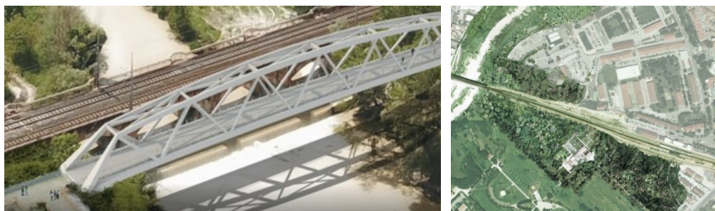
Figura 153: Nuovo ponte ciclopedonale e rigenerazione del Parco XXV Aprile. Fonte: Comune di Pesaro e sito web “Agep”.
