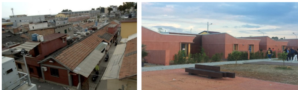
Figura 109: Stato di fatto e avanzamento dei lavori a Fondo Saccà. Fonte: relazione generale, fondazione di comunità di Messina.
