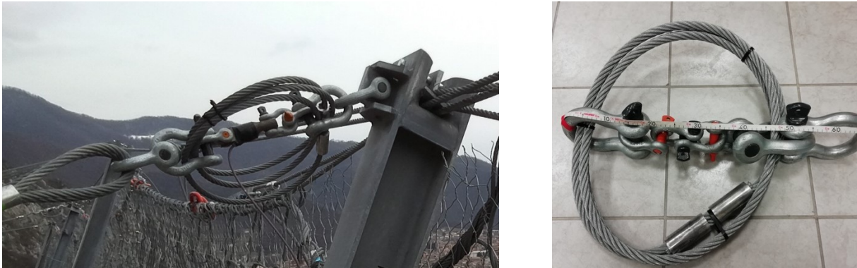
Figura 3.24 Sistema bypass progettato dalla ditta Incofil Tech per ospitare la cella di carico Load Link.
