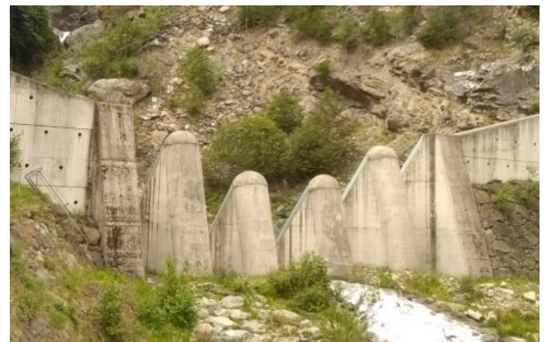
Figura 1.15 a) Bacino di deposito costruito ad Anterselva di mezzo, Bolzano b) Esempio di briglia frangicolata.
