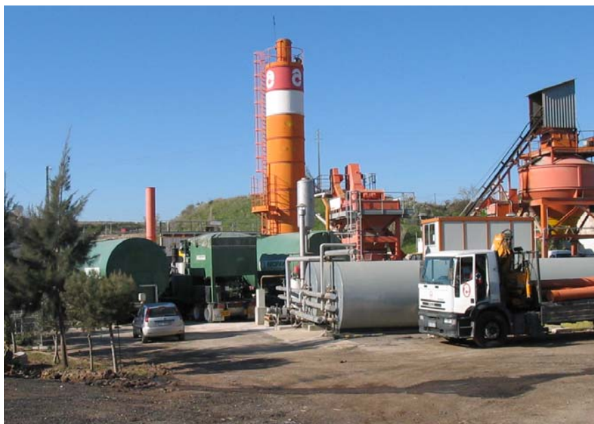
Figura 2-12: Impianto di produzione di Asphalt Rubber della Recipav
