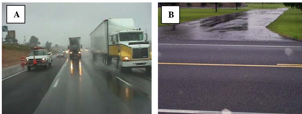
Figura 3-22: Soluzione Asphalt Rubber sulla IH35, San Antonio (Texas). Corsia drenante e corsia tradizionale (A); particolare della superficie finita (B).
