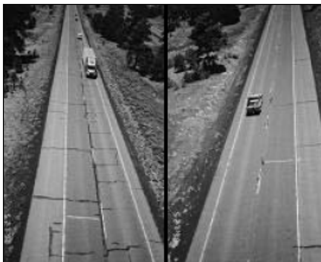
Figura 3-9: Confronto tra due tratti di pavimentazione della I-40, a sinistra in conglomerato tradizionale e a destra in AR, dopo 8 anni di servizio
