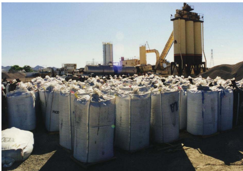
Figura 3-48: Impianto di produzione di AR in funzione. Come si vede non si verificano emissioni di fumi
