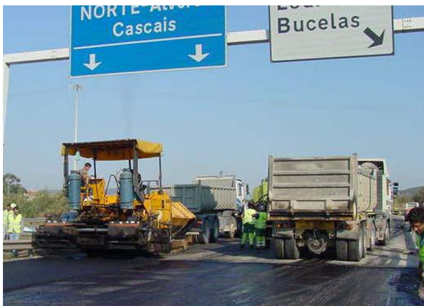
Figura 2-13: Lavori di posa in opera di conglomerato AR
