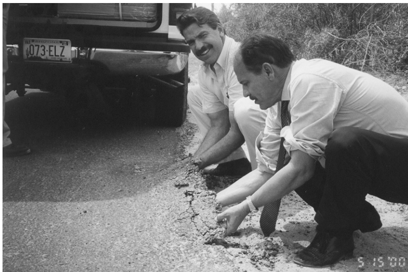
Figura 3-37: Immagine che mostra l'elevata elasticità e resistenza di un trattamento superficiale con AR applicato ad una strada bianca nel deserto dell'Arizona
