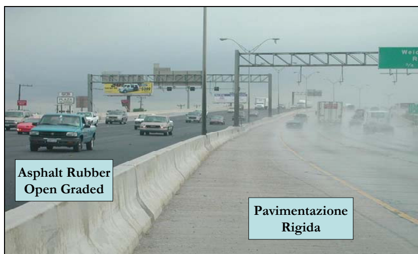
Figura 3-21: Riduzione dell'effetto splash and spray su una superficie in AR-OG (a sinistra) rispetto ad una pavimentazione rigida (a destra)
