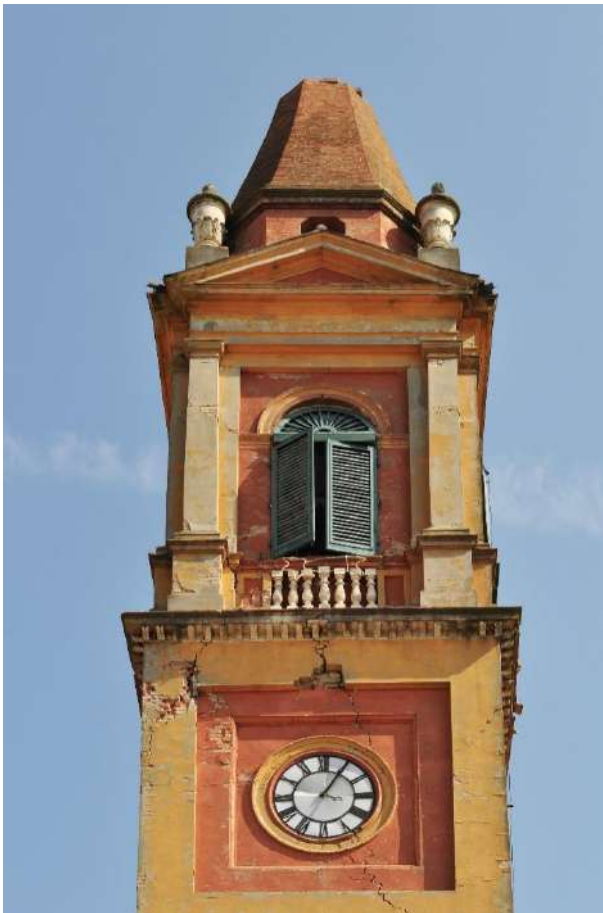
Figura 36: Dissesti nella cella campanaria del campanile della Chiesa di Sant'Agostino a Sant'Agostino (FE).
