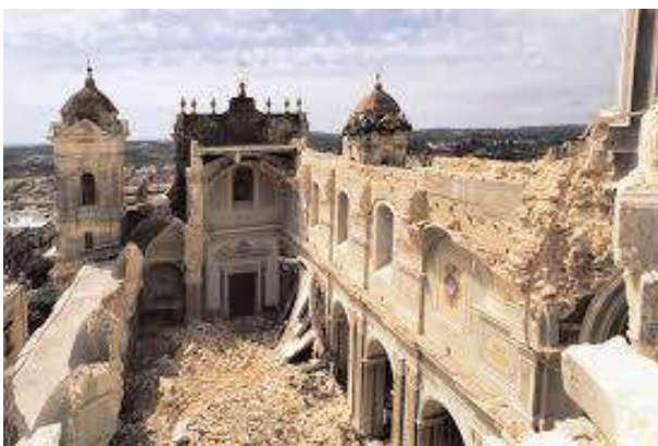
Figura 40: Crollo della cattedrale di Noto a causa dello schiacciamento di un pilastro.
