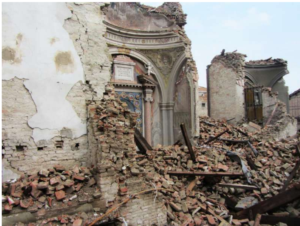
Figura 19: Chiesa di San Felice Vescovo a San Felice sul Panaro (MO). La chiesa è il risultato di progressive aggregazioni, ampliamenti e trasformazioni. In particolare le cappelle, accostate successivamente alla costruzione, hanno manifestato un comportamento diverso dal resto del fabbricato.
