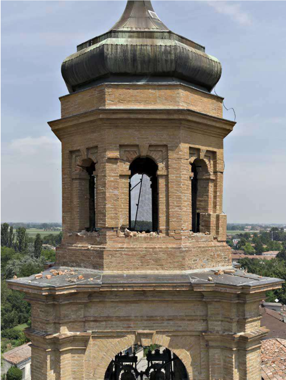
Figura 15: Cella campanaria della Chiesa di Santa Maria Assunta a Reggiolo (RE).
