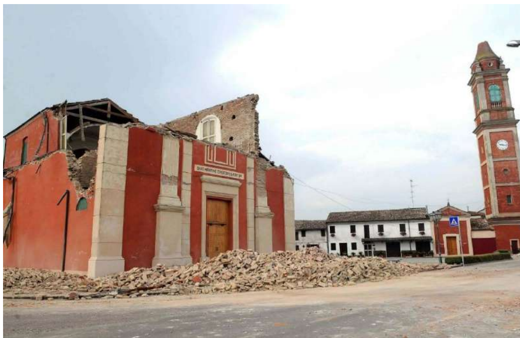
Figura 10: Il campanile di San Martino in località Buonacompria a Cento (FE) e il Municipio del comune di Sant'Agostino (FE) sono stati gli unici casi di demolizione tra gli edifici danneggiati sottoposti a tutela.
