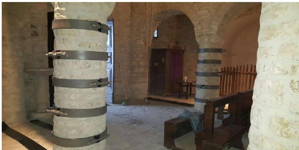
Figura 8: Cerchiatura di confinamento delle colonne della Pieve di San Pietro a Tizzano.
