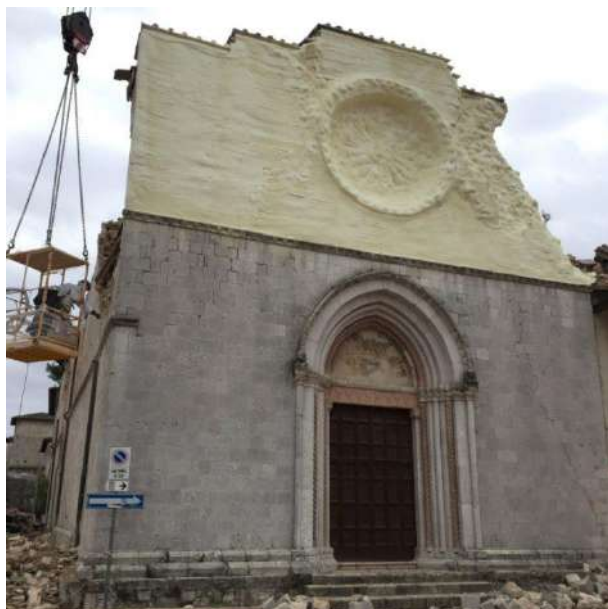
Figura 2: Interventi di somma urgenza per la messa in sicurezza dell'Auditorium Ex-Chiesa di San Francesco a Norcia a seguito dell'evento sismico del 2016. 2
