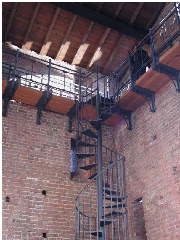
Figura 14: Realizzazione della passerella strutturale di Porta Nuova a Pavia. (Jurina, 2002)
