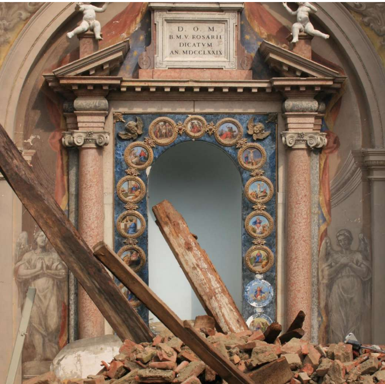
Macerie nella Chiesa di San Felice Vescovo a San Felice sul Panaro (MO) dopo il sisma del 2012.
