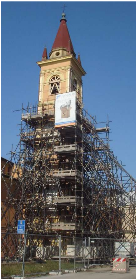
Figura 6: Messa in sicurezza del campanile di San Lorenzo a Casumaro di Cento (FE) con struttura in tubi e giunti.
