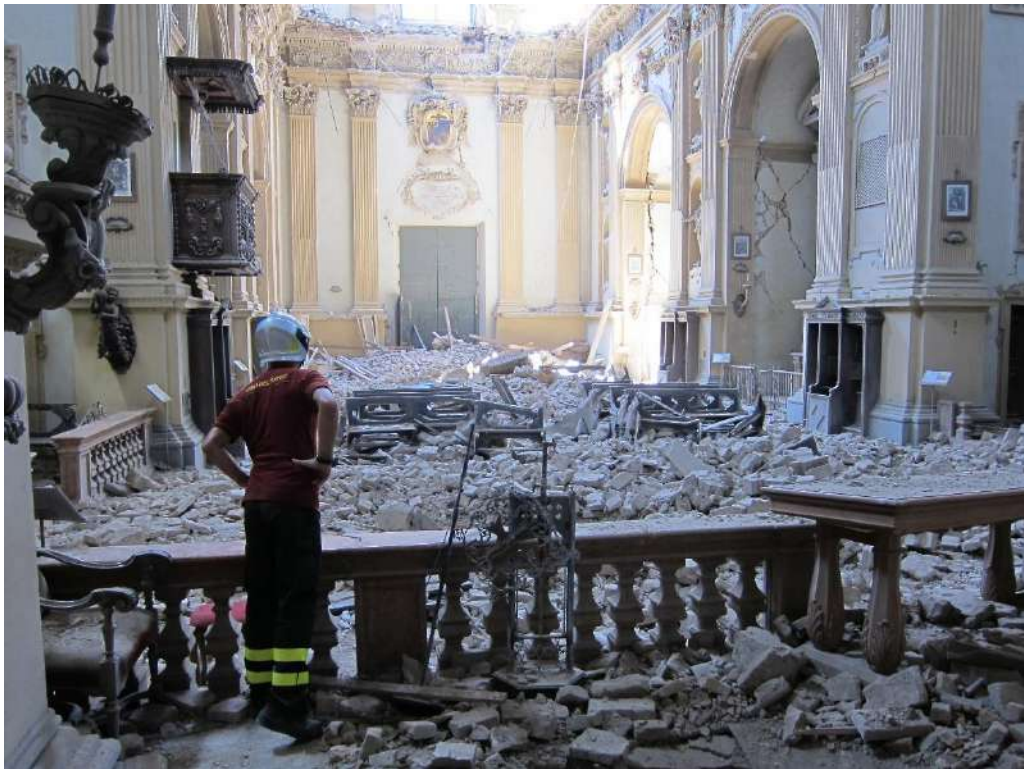
Figura 1: Chiesa del Gesù a Mirandola danneggiata dall'evento sismico del maggio 2012.
