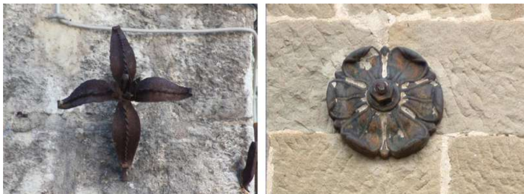
Figura 8: Esempi di capochiave con particolari connotazioni artistiche. A sinistra paletto di ancoraggio decorato con giglio in Palazzo Notar Nanni a L'Aquila; a destra Piastra di ancoraggio con decorazioni floreali nell'Ex Lanificio Lombard a Stia.
