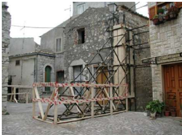
Figura 4: Puntello di ritegno in tubi e giunti nel terremoto del Molise del 2002.
