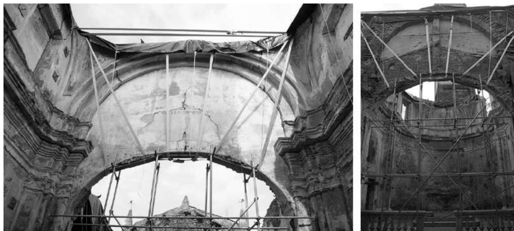
Figura 4: Messa in sicurezza dell'arco trionfale della Chiesa di San Bartolomeo a Salussola (BI).
