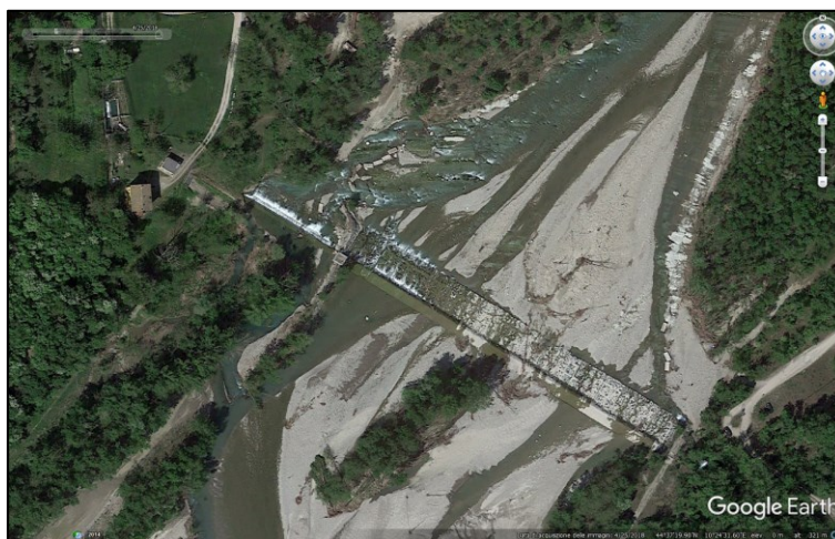
Figura 4.49: Traversa in località Guardasone sul torrente Enza
