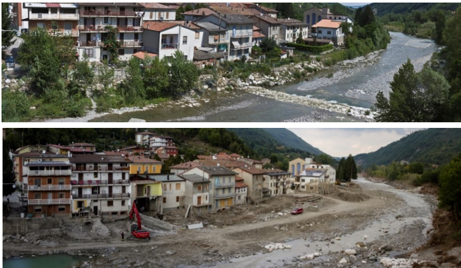
Figura 4.21: Sponda sinistra del torrente Nure in prossimità dell'abitato di Farini prima (sopra) e dopo (sotto) l'evento alluvionale del 13-15 settembre 2015
