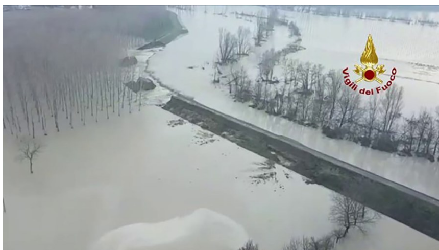
Figura 4.40: Cedimento arginale sul torrente Enza in località Lentigione (RE)
