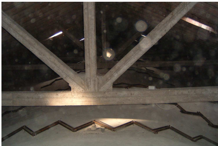
Figura 1.20: L'attuale situazione della copertura della navata centrale.
