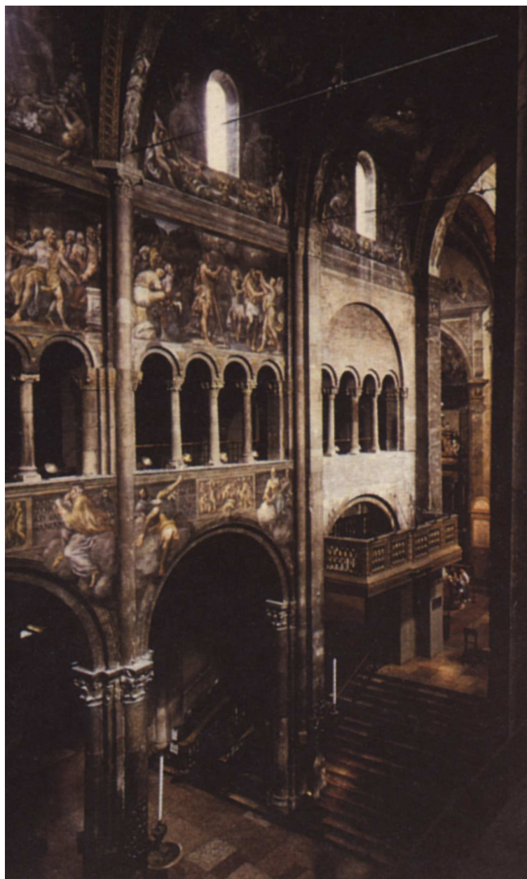
Figura 1.18: L'ultima campata a sinistra rivelò, alla rimozione dell'organo, l'originario arco cieco che inquadrava le quadrifore dei matronei [5].
