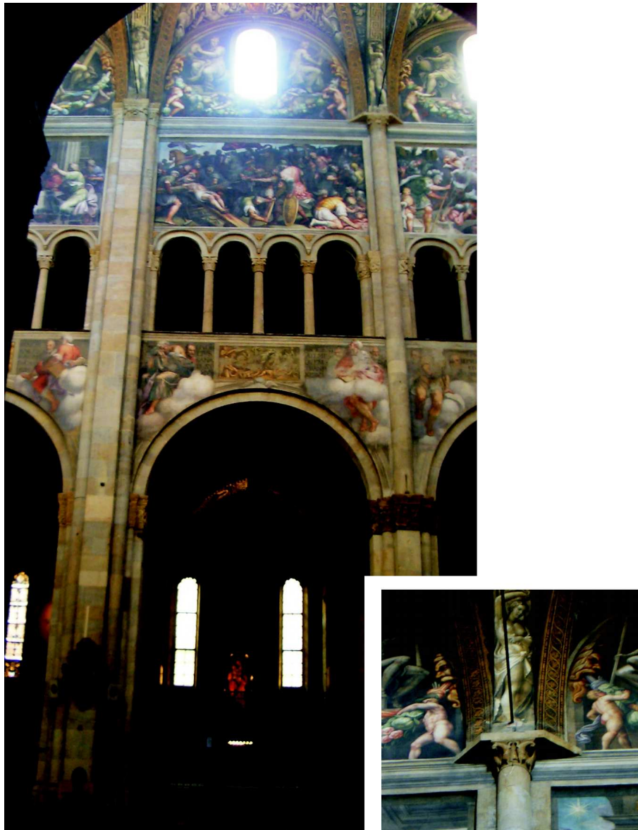
Figura 1.9: I diversi salienti dei pilastri forti e deboli oltre il livello dei matronei. In basso a destra, un dettaglio dell'abaco trapezio in pietra inserito per sostenere, oltre all'arco traverso, i due costoloni delle volte a crociera.
