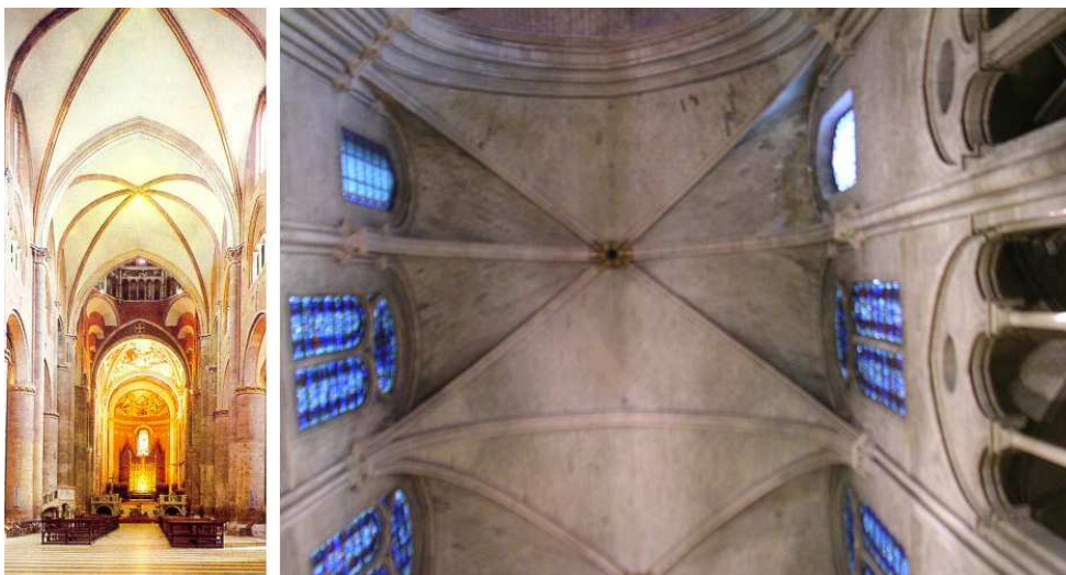
Figura 1.10: Le volte a crociera esapartite del Duomo di Piacenza (fine XII secolo) e di Nôtre Dame di Parigi (1160-1250).
