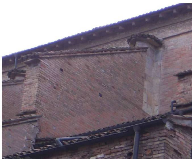
Figura 1.14: Il muro settentrionale della navata centrale: in sommità si nota la sopraelevazione avvenuta nel 1775 e sono ancora evidenti i contrafforti originali a sezione pentagonale.
