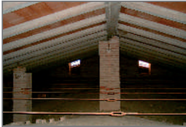
fig.2 sottotetto: volta del '400
