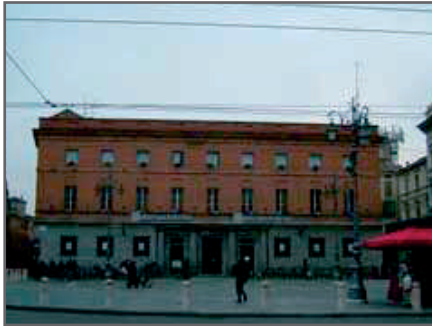
fig. 10 Palazzo del Torello (Bondani) dopo i rifacimenti del Novecento
