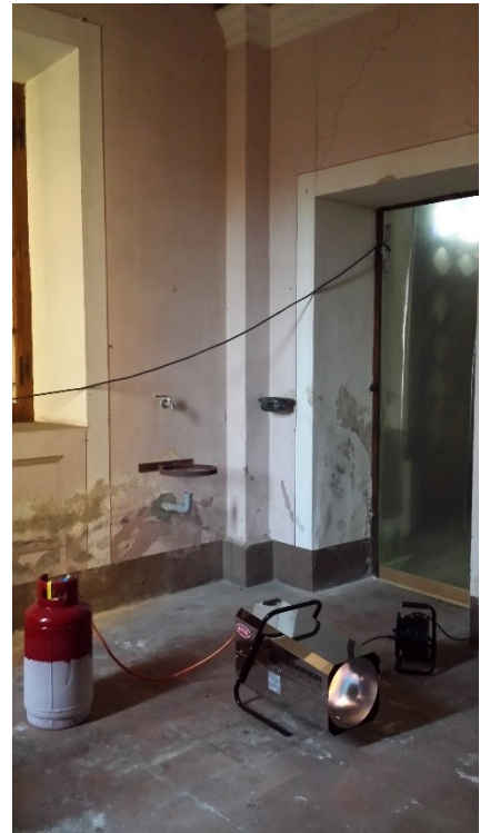
Figura 38 - riscaldamento degli ambienti per le indagini termografiche (*)
