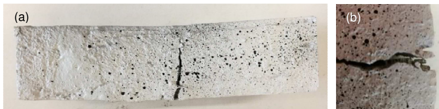
Figura 3.43 Vista globale del provino fessurato (a) e dettaglio della fessura (b)
