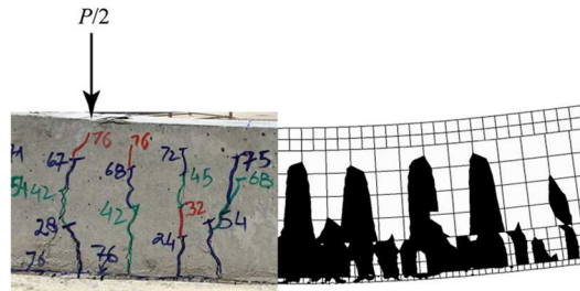
Figura 2.22 Quadro fessurativo a rottura delle travi P-RD12-V1 rinforzate con un singolo strato di composito.
