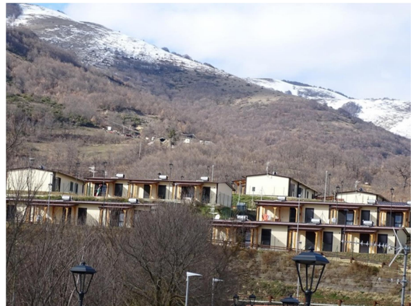
Figura 12 Prefabbricati in legno ad Arquata del Tronto.
