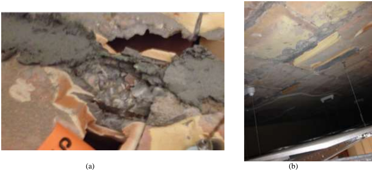
Figura 5.110 – Ispezione visiva del solaio di copertura del secondo piano (punti (a) V3 e (b) V4).
