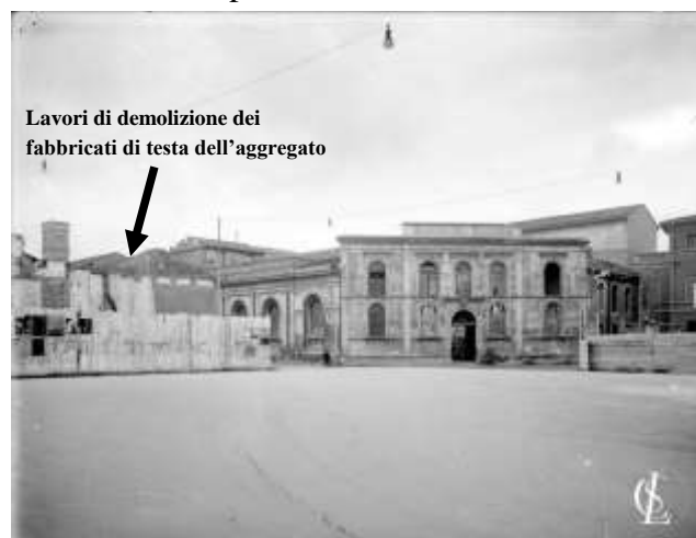
Figura 2.6 – Lavori di demolizione degli edifici di testa dell'aggregato edilizio tra via Mazzini e via Baccarini. Sulla destra è visibile l'Accademia di Belle Arti.
