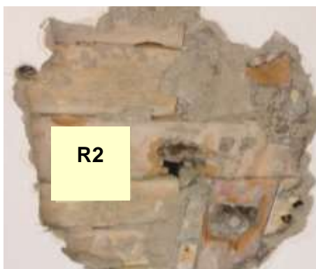
Figura 5.102 – (a) Scansione pacometrica della porzione di solaio in corrispondenza dell'ingresso principale del fabbricato, a piano terra; (b) estratto della relazione di collaudo; (c) saggio diretto.
