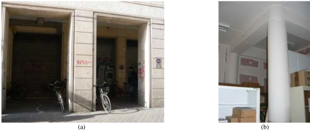
Figura 1.37 – Pilastri in c.a. al piano terra (a) sul perimetro esterno e (b) all'interno del fabbricato.
