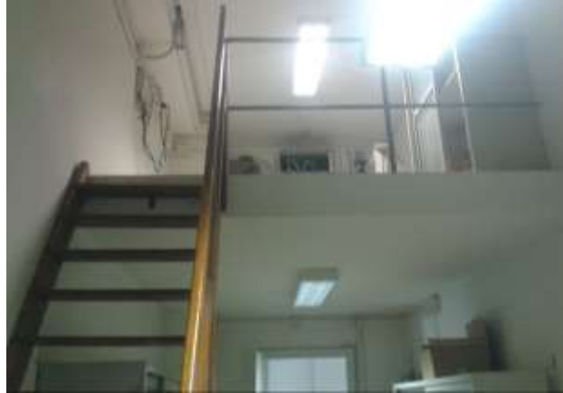
Figura 6.20 – Soppalco interno, al piano secondo.
