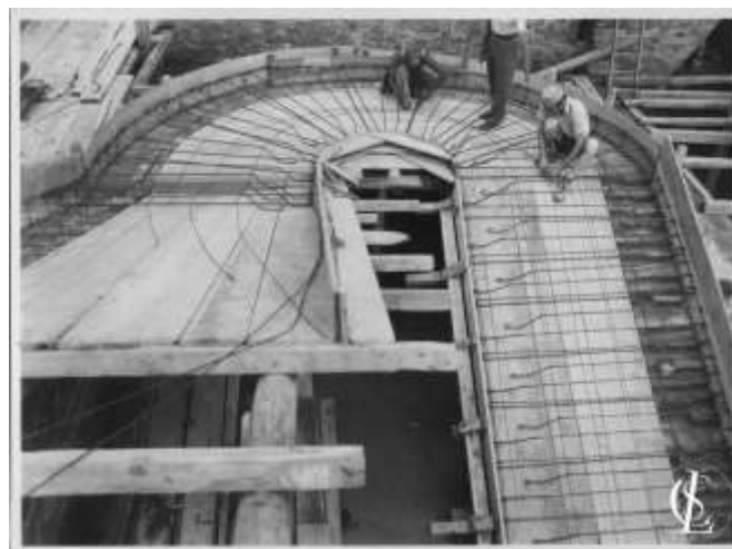
Figura 2.25 - Realizzazione della prima rampa dello scalone principale.
