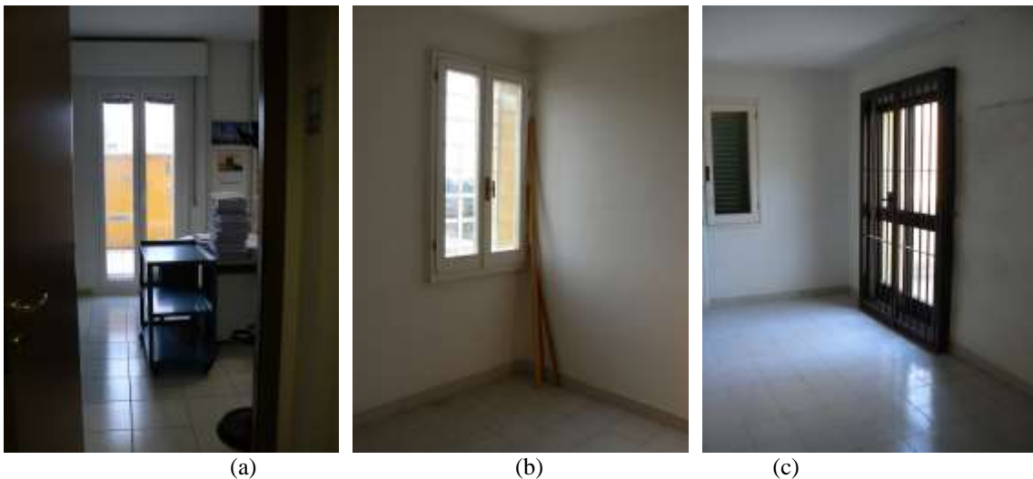
Figura 5.121 – Vista di alcuni infissi presenti nello stabile.
