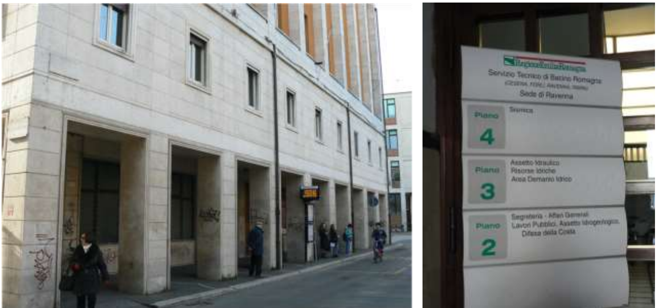
Figura 1.12 – Ingresso principale del fabbricato.
