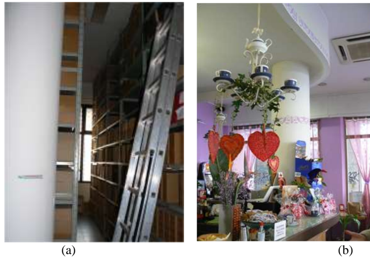
Figura 1.14 – Piano terra: (a) locali adibiti a deposito/archivio e (b) ambiente in locazione a privati, ad uso bar.
