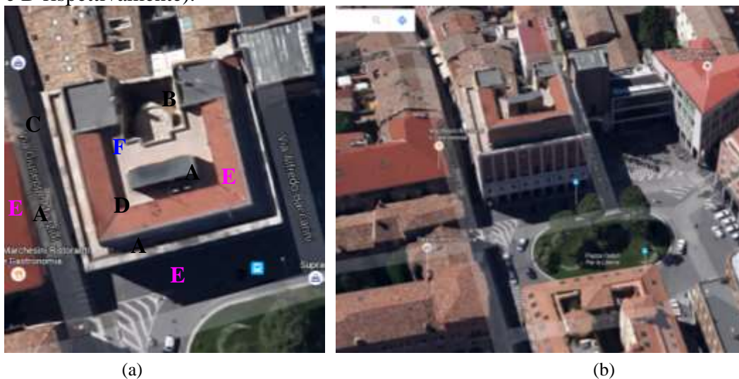
Figura 6.6 – Vista aerea della copertura della sede S.T.B. (da Google Maps).
