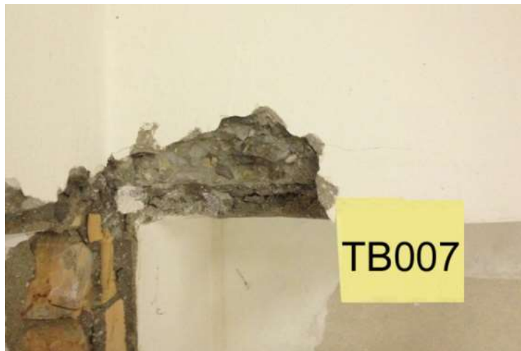
Figura 5.63 – Sondaggio sulla trave TB007 al piano terra.
