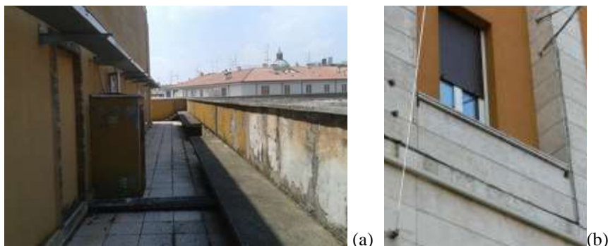
Figura 6.29 – (a) Terrazzo al piano quarto: vista della soletta di corredo in c.a. con funzione di camminamento; (b) balconcini al piano secondo
