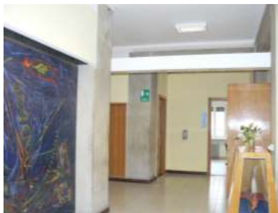
Figura 5.89 – Vista di alcuni pilastri al piano primo.
