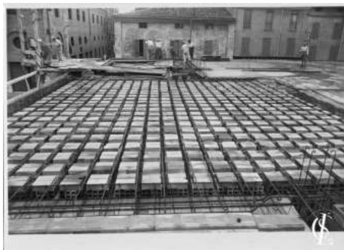
Figura 2.18 – Realizzazione dei solai tra piano terra e piano primo, nella porzione di fabbricato prospiciente Piazza Caduti per la Libertà.
