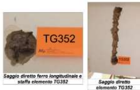
Figura 5.82 – Rilievo dell'elemento orizzontale in c.a. TG, lato corridoio principale al piano terzo (foto dei sondaggi).
