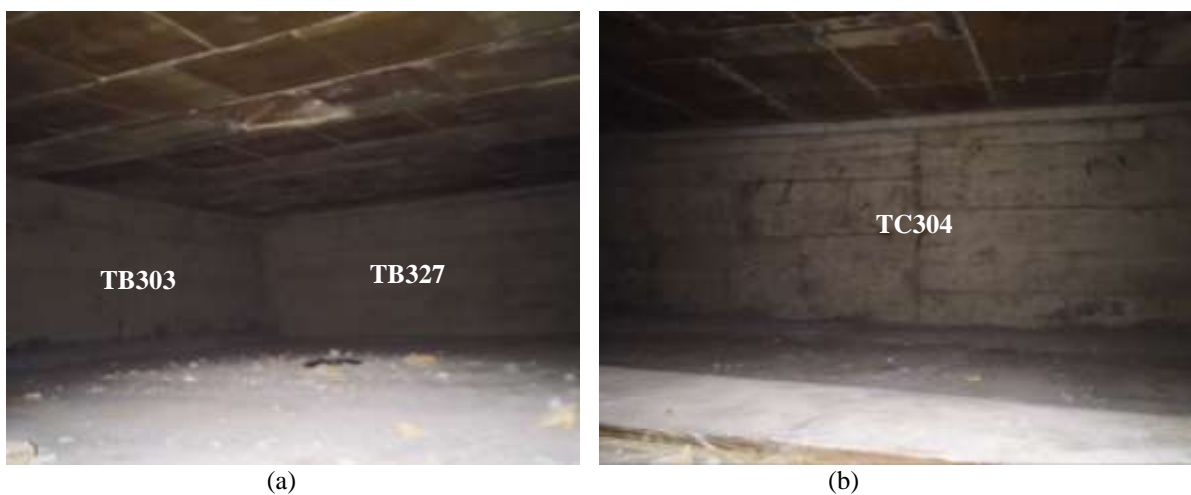
Figura 5.79 – Esame visivo delle travi del terzo piano poste in corrispondenza del corridoio centrale, lato Piazza.
