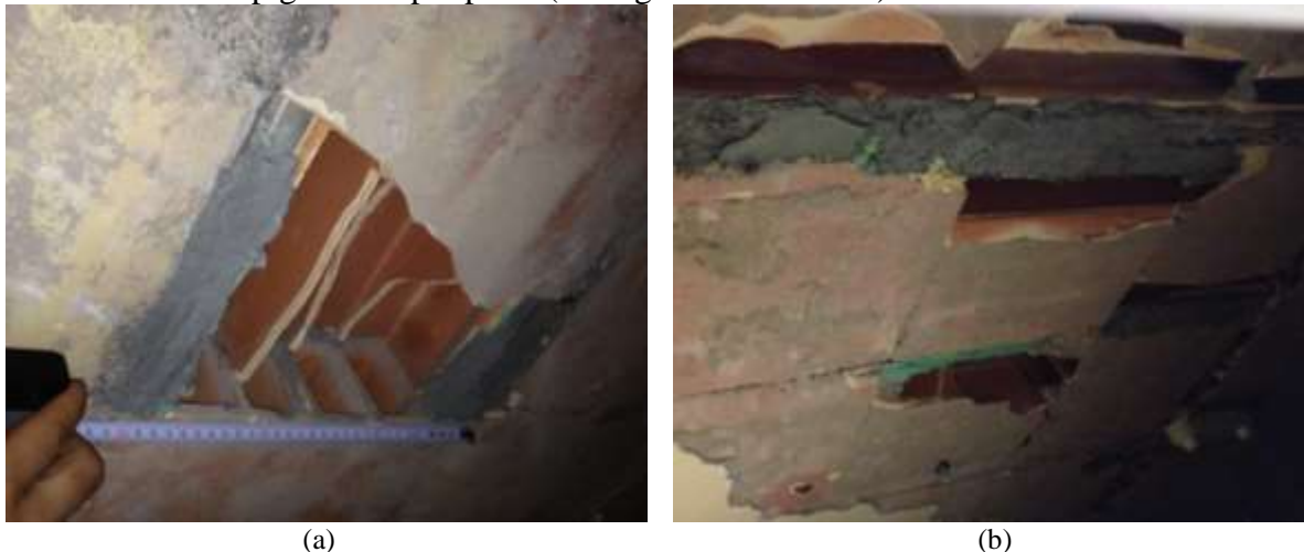
Figura 5.109 – Ispezione visiva del solaio di copertura del secondo piano (punto V5).
