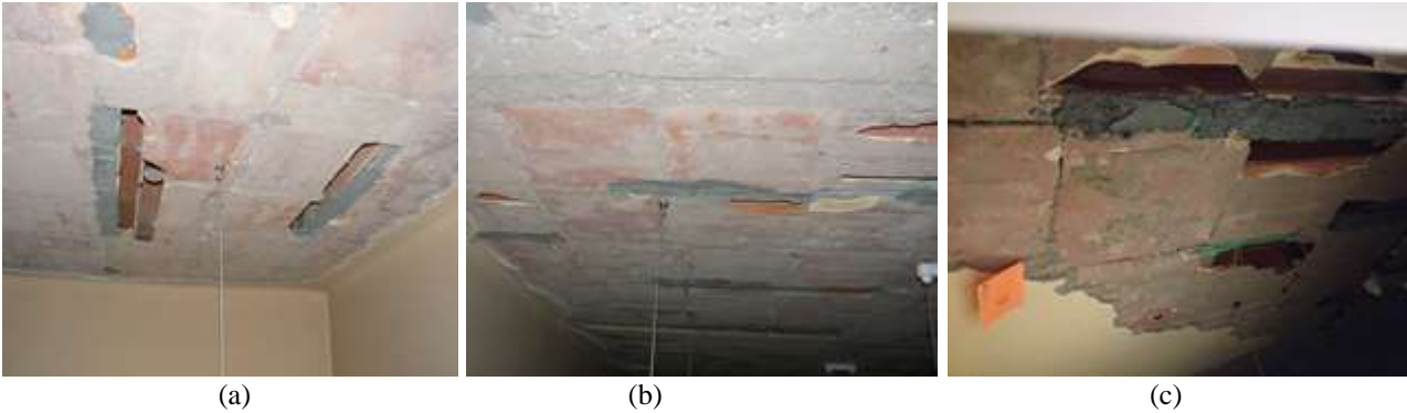
Figura 5.118 – Piano secondo: situazione di alcuni solai al di sotto dei controsoffitti.
