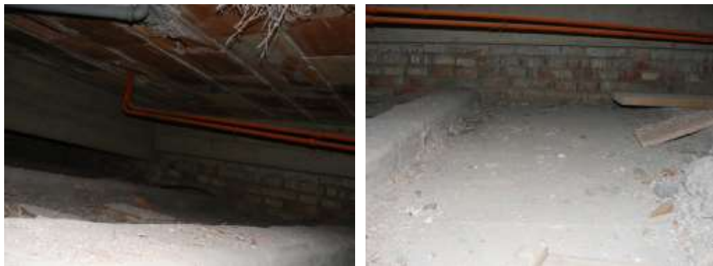
Figura 5.119 – Piano terzo: vista del controsoffitto fisso, come appare da una delle tre botole di ispezione presenti.
