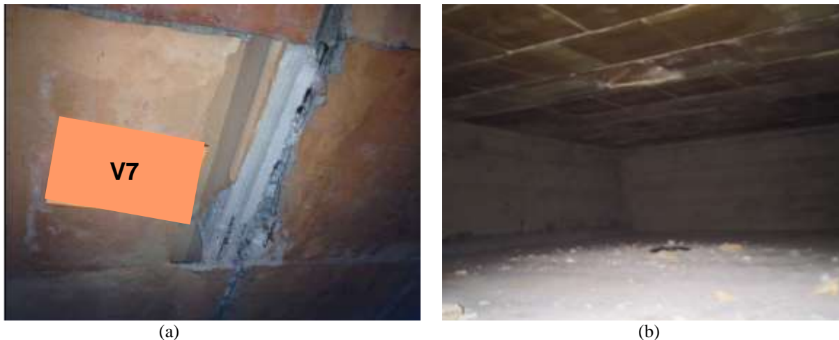
Figura 5.112 – Ispezioni visive (a) V7 e (b) V8 sul solaio di copertura del piano terzo.
