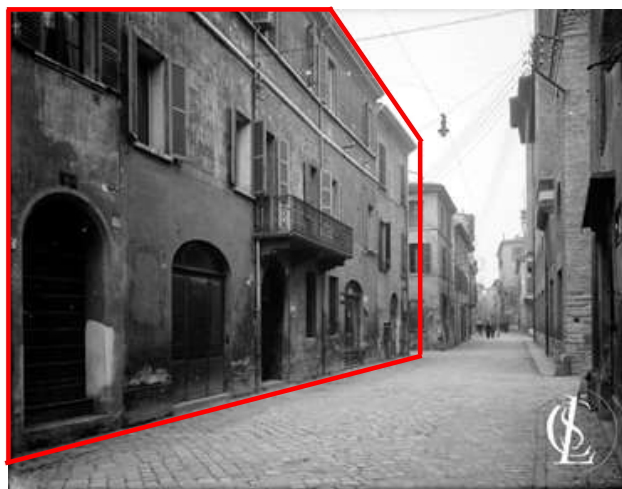
Figura 2.3 - Porzione di aggregato edilizio tra via Mazzini e via Baccharini abbattuto per costruire il Palazzo delle Corporazioni (sulla sinistra, nel riquadro rosso).
