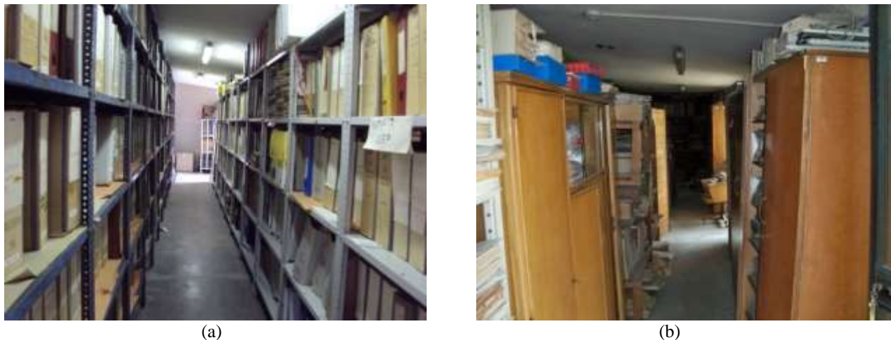
Figura 5.5 – (a), (b) vista di due locali al quinto piano adibiti ad archivio e deposito.
