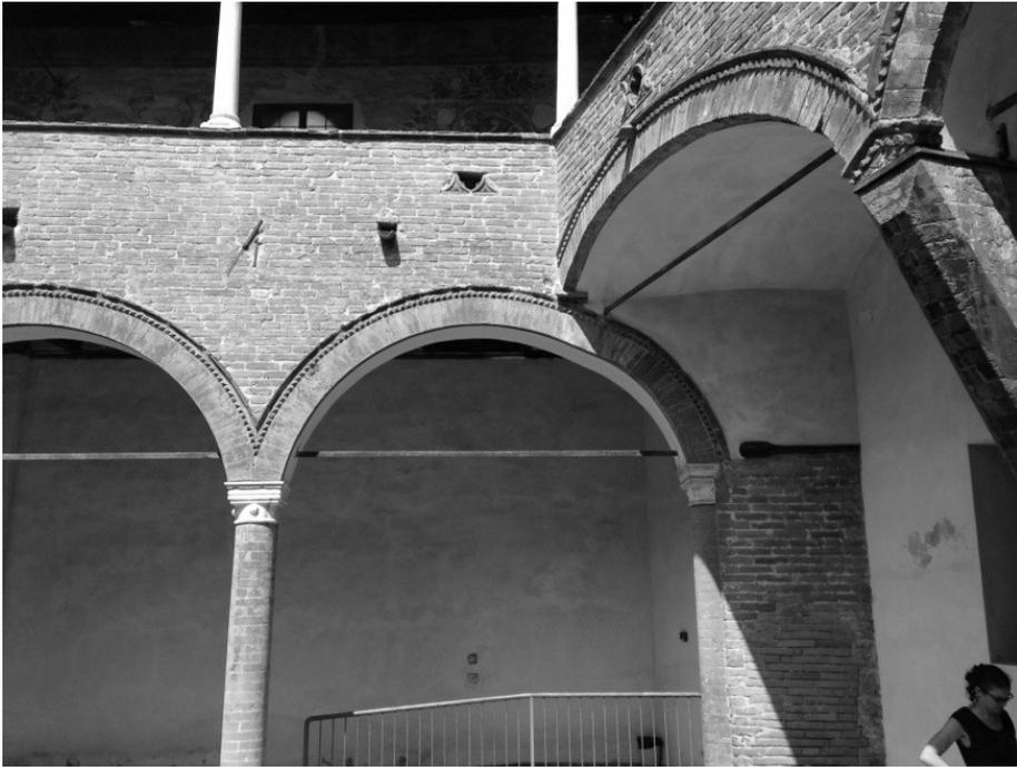
*Figura 121 Arco in angolo est del loggiato sul lato nord del cortile minore in corrispondenza dell'intersezione con l'arco delle baldresche con evidenti segni di deformazione; il confronto fra la situazione deformata e la possibile conformazione iniziale indeformata è di notevole importanza per la determinazione dell'evolversi del quadro degli stati tensionali, dei quadri fessurativi e di deterioramento e conseguentemente per meglio proporre gli eventuali interventi di consolidamento.*
