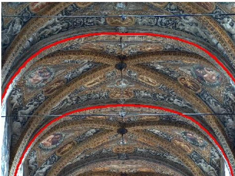
*Figura 74 Cattedrale di Parma, arconi trasversali della navata centrale, evidenti segni di deformazioni con forte abbassamento della chiave che ha portato ad un profilo intradossale della parte centrale dell'arco tendente all'orizzontalità.*
