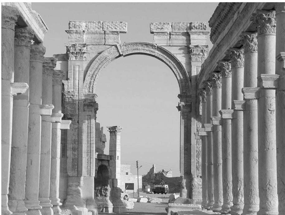
*Figura 1 Sito archeologico di Palmyra (Siria), arco severiano sulla via colonnata, 120 d.C. circa. Dissesto di arco in conci di pietra per rotazione del piedritto e scorrimento verticale del concio di chiave (1992).*
