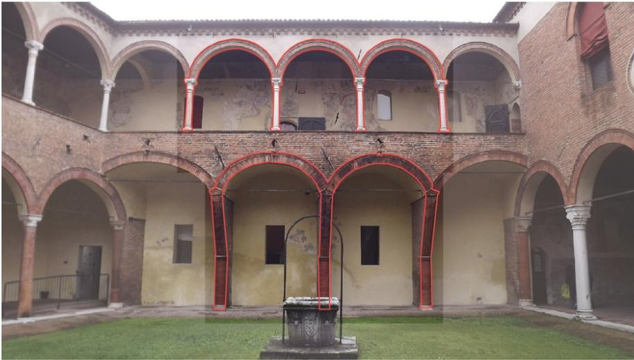
*Figura 123 Individuazione delle due baldresche e le tre arcate superiori ricostruite nell'intervento del 1924: l'arco piano terreno a nord (sinistra della foto) e l'arco piano terreno a sud (destra della foto) agiscono puntualmente a circa ½ dall'imposta degli archi ortogonali dei rispettivi fronti nord e sud.*
