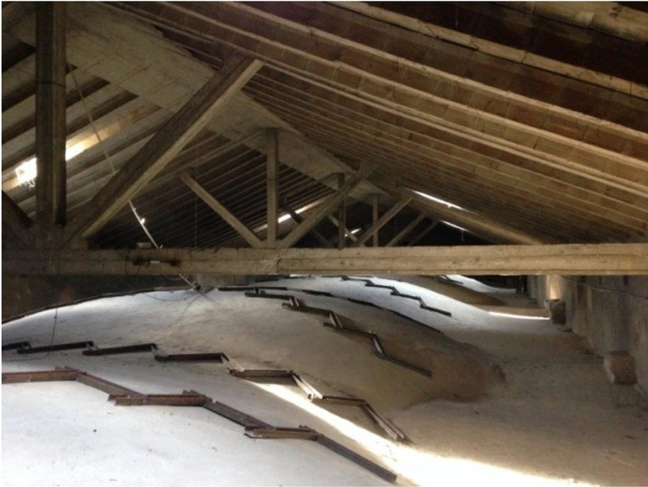
*Figura 73 Cattedrale di Parma, sottotetto della navata centrale, gli interventi alle coperture del 1951 vedono la creazione di una nuova struttura con capriate in conglomerato cementizio armato e travetti prefabbricati che, rispetto alle precedente lignea, presenta una massa maggiore.*
