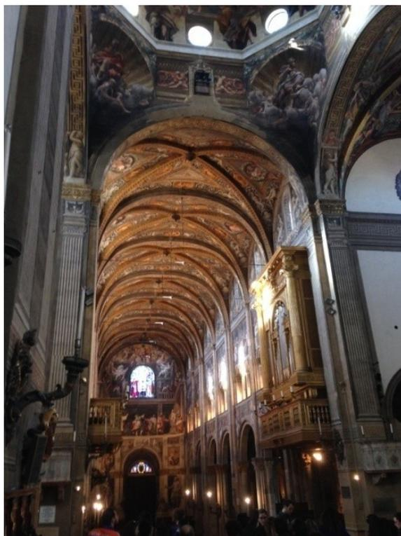
*Figura 72 Cattedrale di Parma, navata centrale vista dal presbiterio, gli abbassamenti in chiave degli archi e conseguentemente delle volte si evidenziano lungo tutta la navata.*
