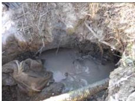
Fig. 10.18 Immagine della tana quasi completamente riempita con la miscela cemento-bentonite.
