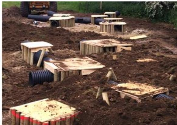
Fig. 10.11 Esempio di realizzazione di tane artificiali: in legno e compensato sono costruite le camerette collegate tramite un sistema di tunnel con tubazioni in plastica.
