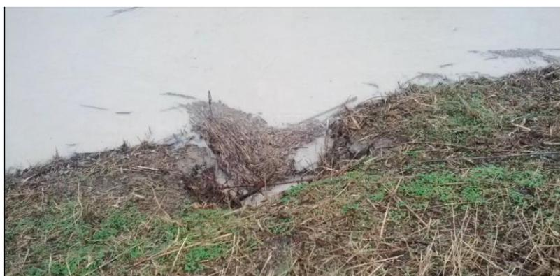
Fig. 4.5 Imbocco del flusso d'acqua incanalatosi all'interno di una tana nell'argine del fiume Panaro contemporaneamente alla vicina rottura dell'argine del fiume Secchia il 19/01/2014.
