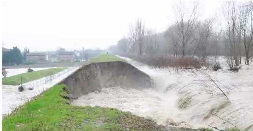
Fig. 4.2 Rottura dell'argine destro del fiume Secchia del 19/01/2014.
