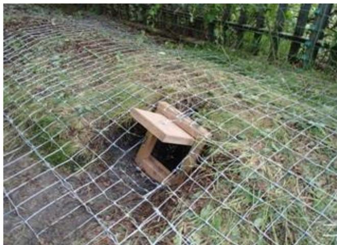
Fig. 10.13 Esempio di rilevato ricoperto con rete zincate e con ingresso unidirezionale.
