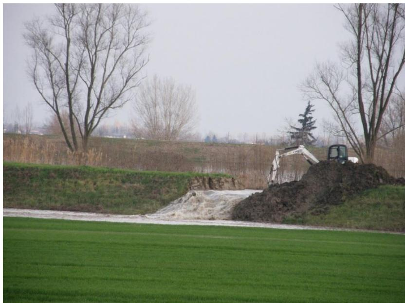
Fig. 4.3 Lavori per fermare il flusso di acqua in uscita dalla breccia dell'argine destro del fiume Secchia relativi all'evento 19/01/2014.
