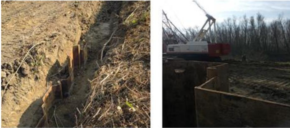
Fig. 10.3 Dettagli di diaframmatura realizzata con palancole in metallo.
