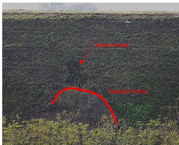
Fig. 10.9 Tana di tasso scavata su arginatura in cui è evidente il grosso cumulo di terra rimossa dal rilevato.
