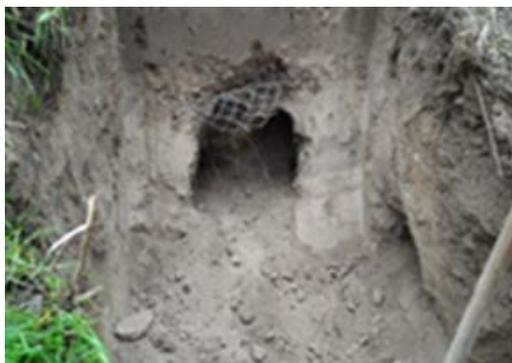
Fig. 10.16 Lavori di ripristino delle arginature danneggiate dall'azione di scavo del tasso: si notano le ramificazioni della tana e un lembo della rete che era posta a chiusura di tane scavate in precedenza.
