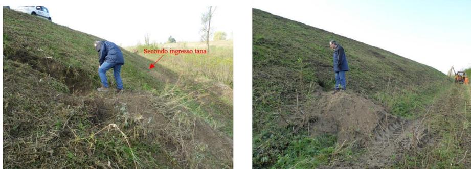
Fig. 10.15 Tana di tasso rinvenuta lungo l'arginatura destra del fiume Panaro (Mo) lato fiume in cui si possono notare i due ingressi e i cumuli di terra prodotti dallo scavo dell'animale.
