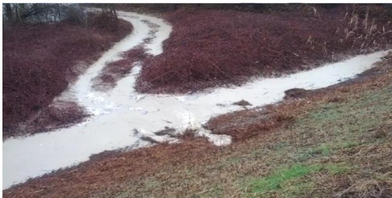
Fig. 4.6 Flusso d'acqua in uscita da una tana nell'argine del fiume Panaro contemporaneamente alla vicina rottura dell'argine del fiume Secchia il 19/01/2014.
