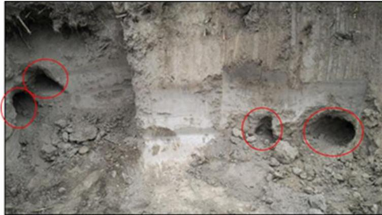
Fig. 10.8 Immagine scattata in destra idraulica Panaro (Mo), lato fiume che mostra le ramificazioni della galleria scavata dal tasso all' interno del rilevato arginale, rinvenute durante le operazioni di scavo meccanico nell' ambito dei lavori di chiusura delle tane.
