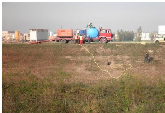
Fig. 10.17 Approntamento del cantiere per il riempimento della tana scavata dal tasso con miscela di cls e bentonite. (AIPo, 2015).
