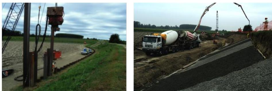
Fig. 10.6 Interventi di limitazione del fenomeno di filtrazione in Via Bozzala (Cavezzo, Mo) tramite infissione di palancole e successivo rivestimento del paramento arginale lato fiume in c.a. (Aipo, 2015).
