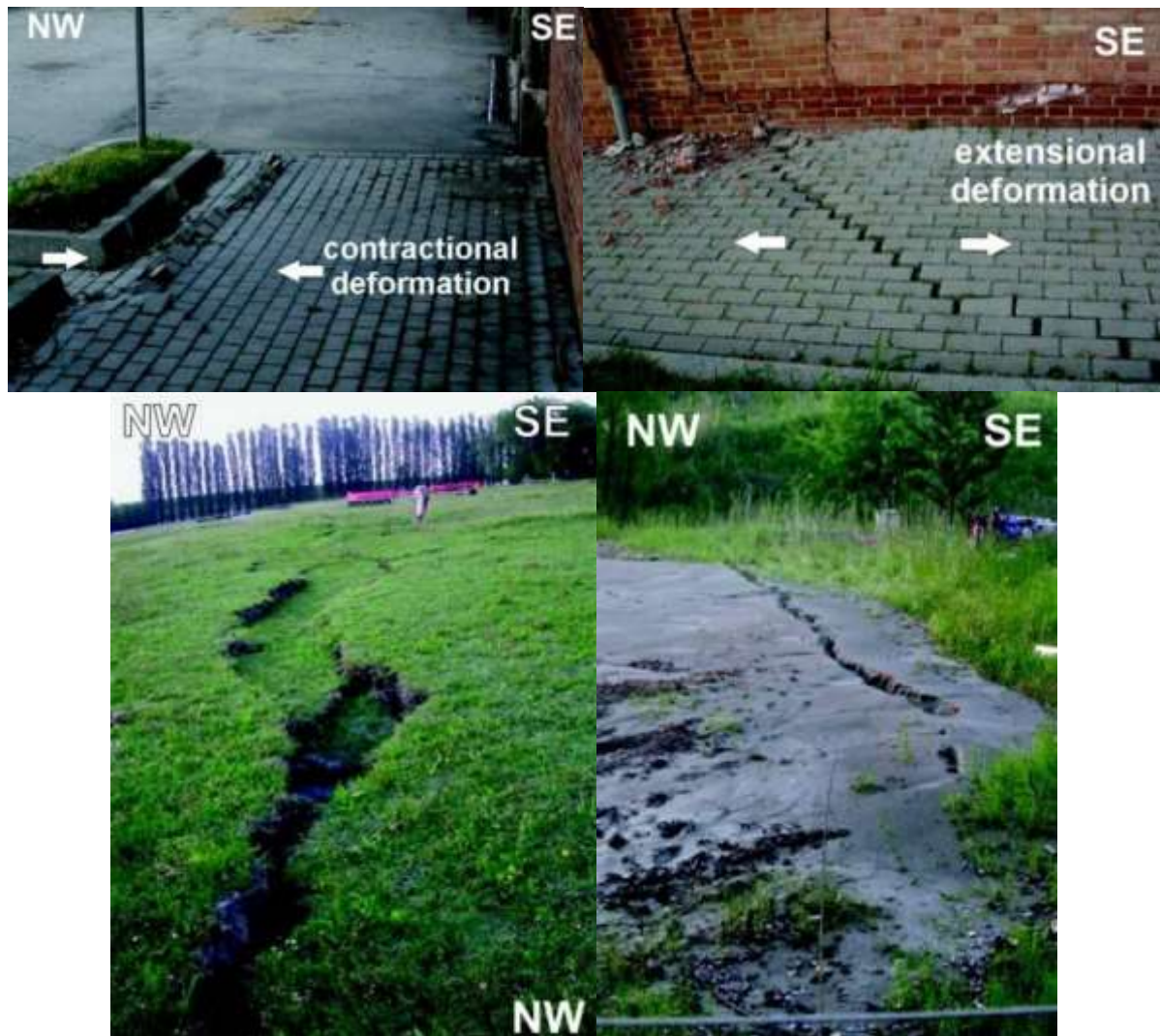
Fig. 3. 16 – Esempi di fenomeni cosismici superficiali rilevati a seguito della sequenza sismica emiliana nelle vicinanze del dosso di Sant’Agostino (da Pizzi & Scisciani, 2012).
