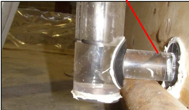
Foto 27. Sistema di alimentazione del diffusore anodico rivestito di geotessile.
