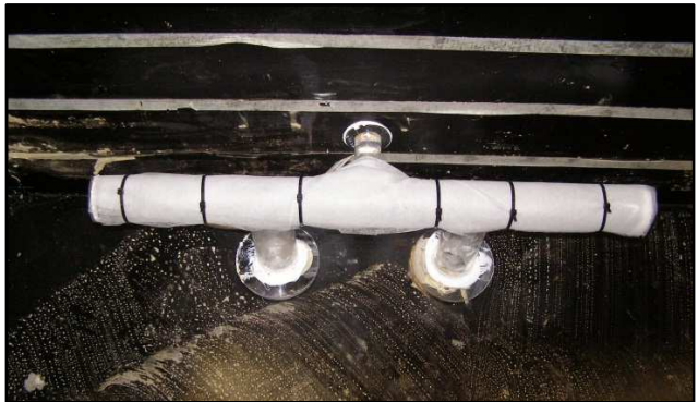
Foto 27. Sistema di alimentazione del diffusore anodico rivestito di geotessile.
