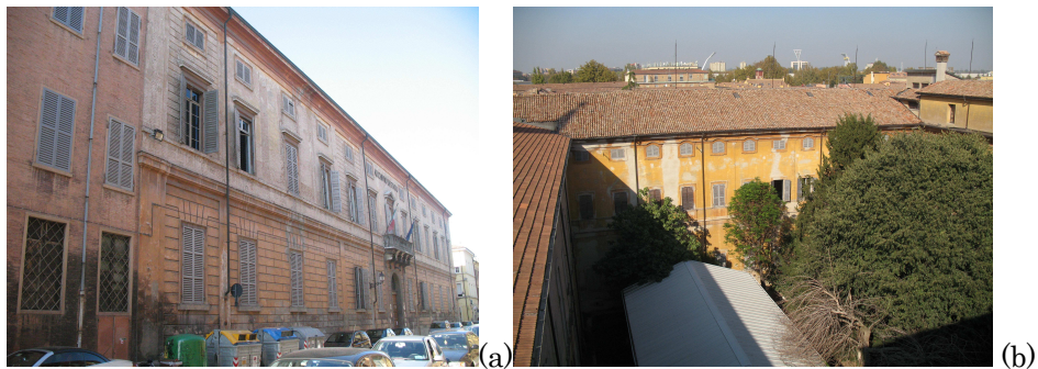
Figura 9.33- (a) Prospetto lato ingresso, (b) prospetto lato cortile interno.
