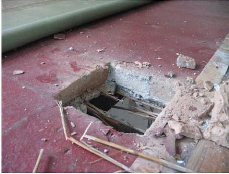
Fig. 4 vista da sopra degli strati di un solaio
