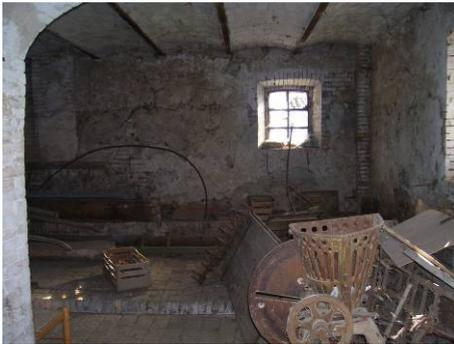
Fig. 10 solaio di separazione tra stalla e fienile con voltine in ferro e laterizio
