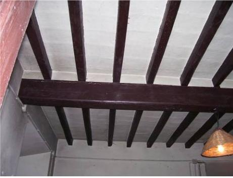
Fig. 65 intradosso di un solaio tipo delle abitazioni
