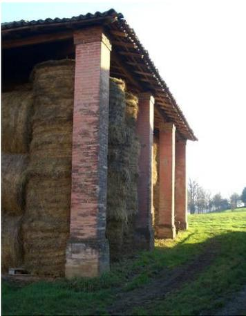
Fig. 18 vista di pilastri in mattoni a sostegno di un portico esterno
