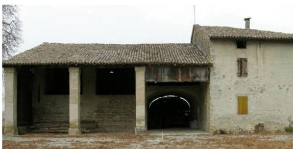
Fig. 9 Prospetto di edificio con porta morta
