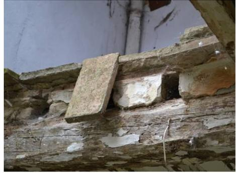
Fig. 5 vista da sotto degli strati di un solaio
