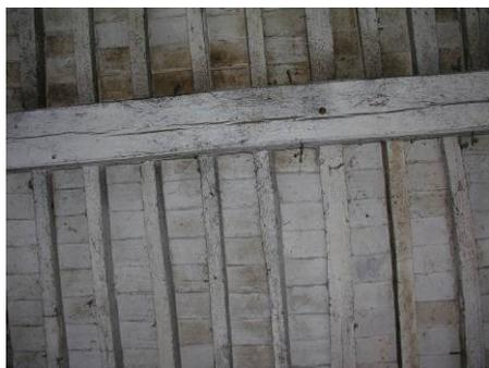
Fig. 17 intradosso di un solaio tipo dell'abitazione
