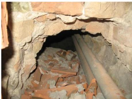
Fig. 1 impianto inserito sotto traccia
