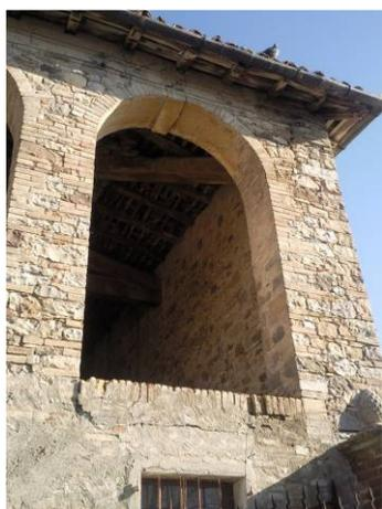
Fig. 20 apertura del fienile ad arco e mattoni disposti a coltello
