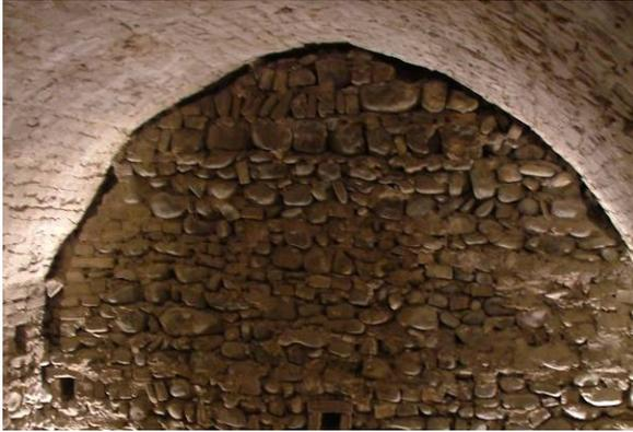
Fig. 8 volta con mattoni di costa
