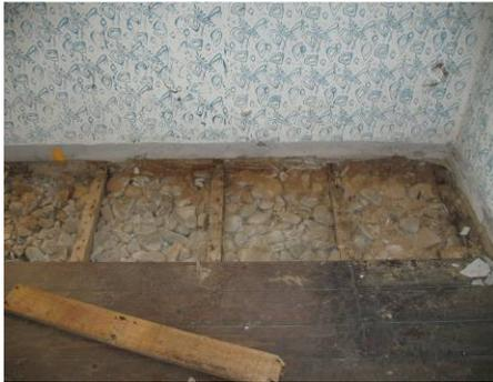
Fig. 2 solaio a terra su ciottoli di un'abitazione
