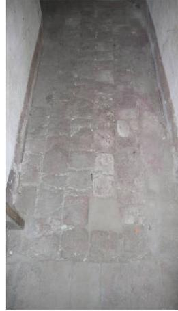
Fig. 61 estradosso di un solaio del casale
