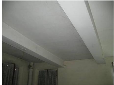
Fig. 7 solaio rivestito in arellato
