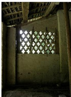
Fig. 37 vista dall'interno della chiusura a gelosia del fienile
