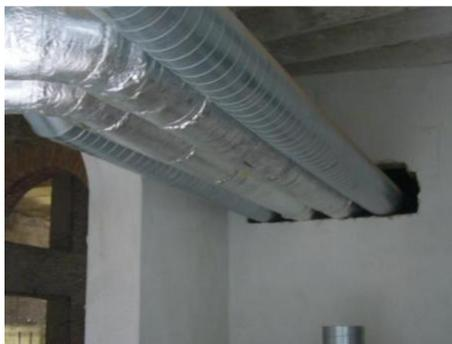
Fig. 4 canalizzazioni molto invasive lasciate a vista, senza alcuna valenza architettonica
