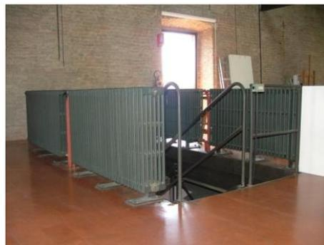
Fig. 2 terminali a vista con valenza architettonica
