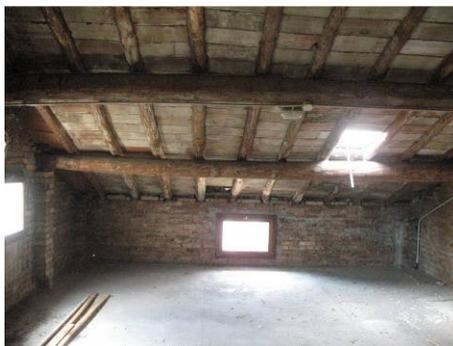
Fig. 15 copertura in legno con travi, travetti e tavelle in laterizio
