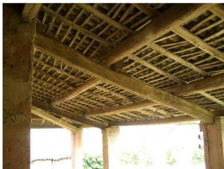
Fig. 14 copertura in legno con travi, travetti, listelli e correntini
