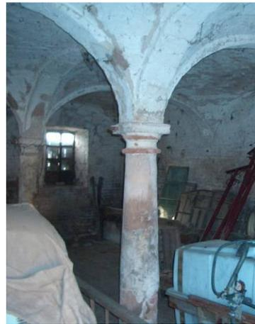
Fig. 19 vista di colonne in mattoni intonacati all'interno di una stalla
