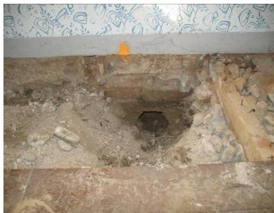
Fig. 1 particolare del carotaggio di un muro di fondazione in mattoni
