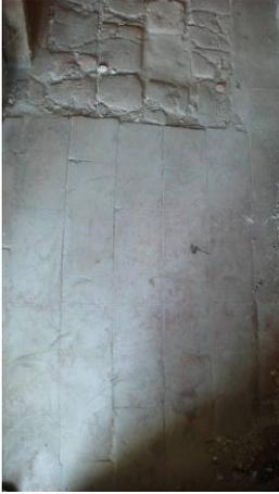
Fig. 60 estradosso di un solaio del casale
