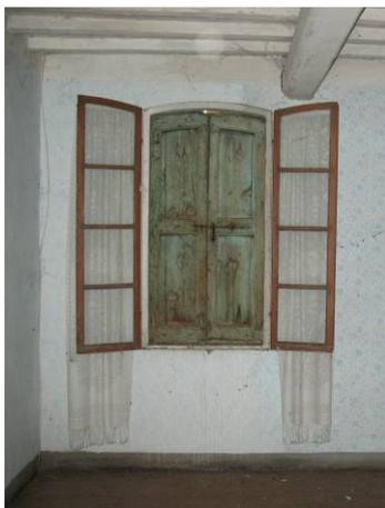
Fig. 22 finestra di un'abitazione rurale, con infisso in legno e scuro verniciato
