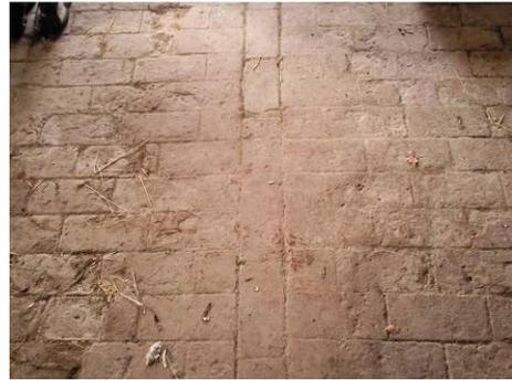
Fig. 3 solaio a terra in cotto di una stalla
