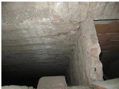
Fig. 3 cavedio preesistente sfruttabile come vano tecnico per il passaggio degli impianti
