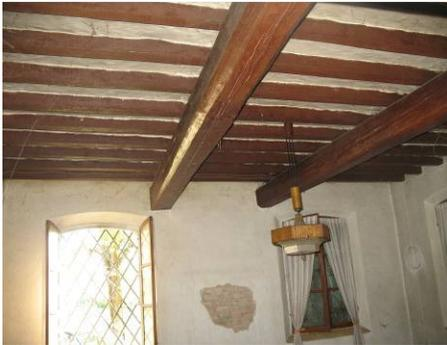
Fig. 6 solaio a struttura lignea a vista
