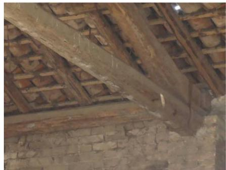
Fig. 13 particolare di copertura con dormiente
