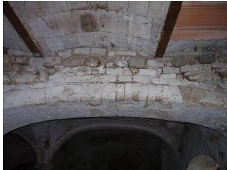
Fig. 11 particolare dell'attacco al muro delle voltine in ferro e laterizio
