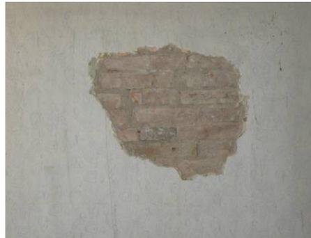
Fig. 17 muro in mattoni di laterizio parzialmente coperto da intonaco
