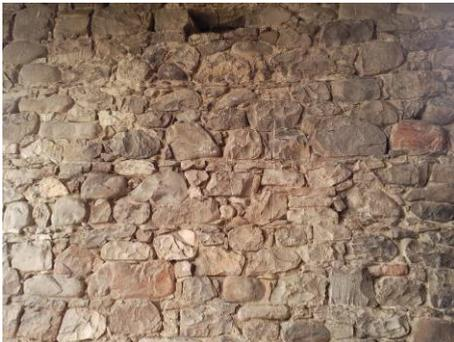
Fig. 16 muro in conci di pietra sbozzati con tessitura non omogenea
