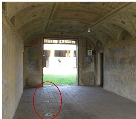
Fig. 114 chiusure incongrue sulla pavimentazione del piano terra
