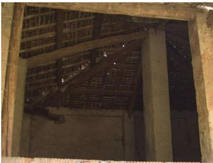
Fig. 12 copertura a più falde con puntoni diagonali
