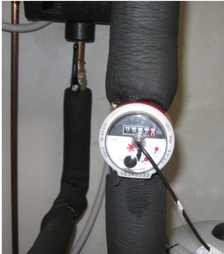
Figura 4.12– Contatore volumetrico.
