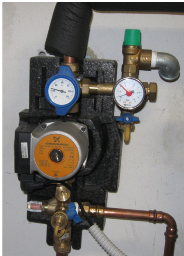
Figura 4.5 – Stazione solare.
