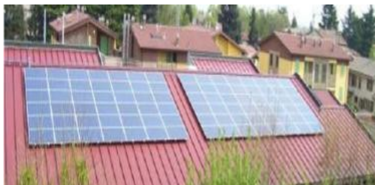
Figura 3.1 – Copertura Casa protetta.
