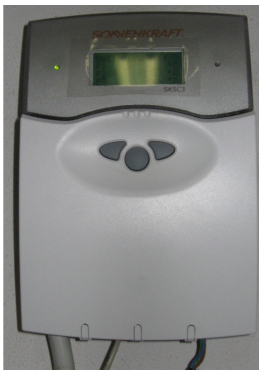
Figura 4.17 – Centralina solare.
