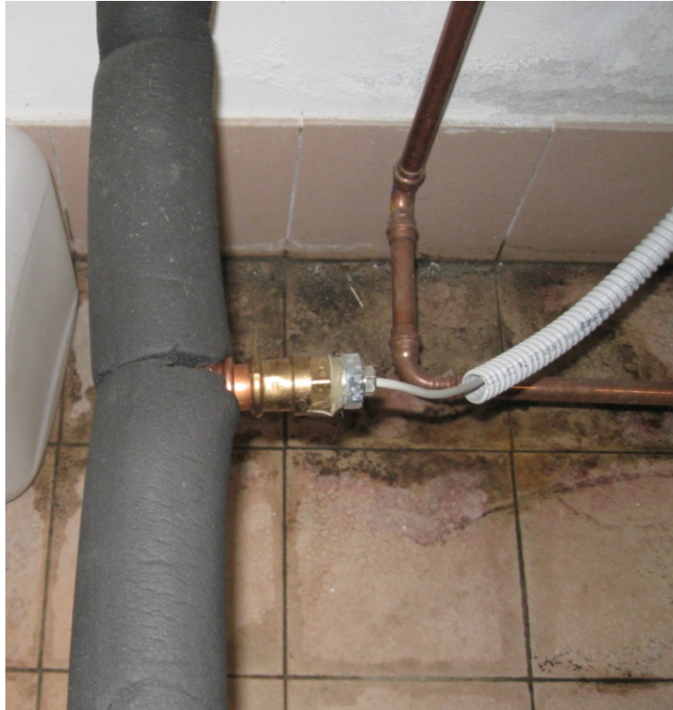
Figura 4.10 – Sonda di temperatura sulla tubazione di mandata ai collettori solari.
