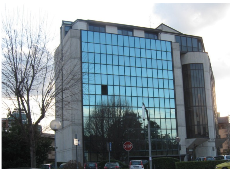
Figura 1.2 – Visualizzazione dell'edificio (esposizione NORD).
