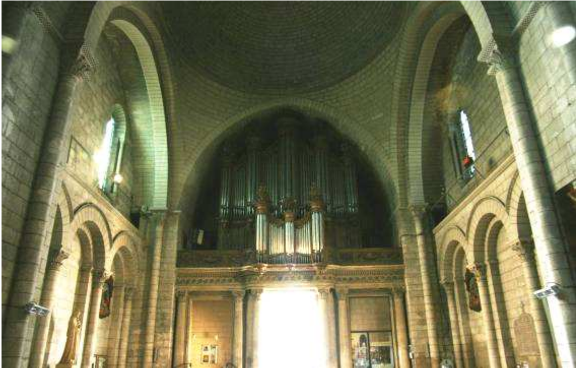
Fig. IV.14 Angoulême, cattedrale di Saint-Pierre, interno.
