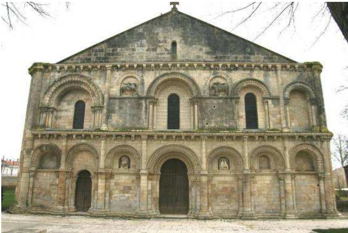
Fig. V.13 Surgères, Notre-Dame, facciata.
