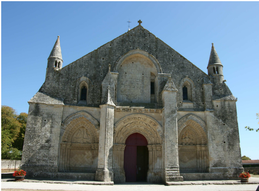
Fig. IV.81 Aulnay, Saint-Pierre, facciata.
