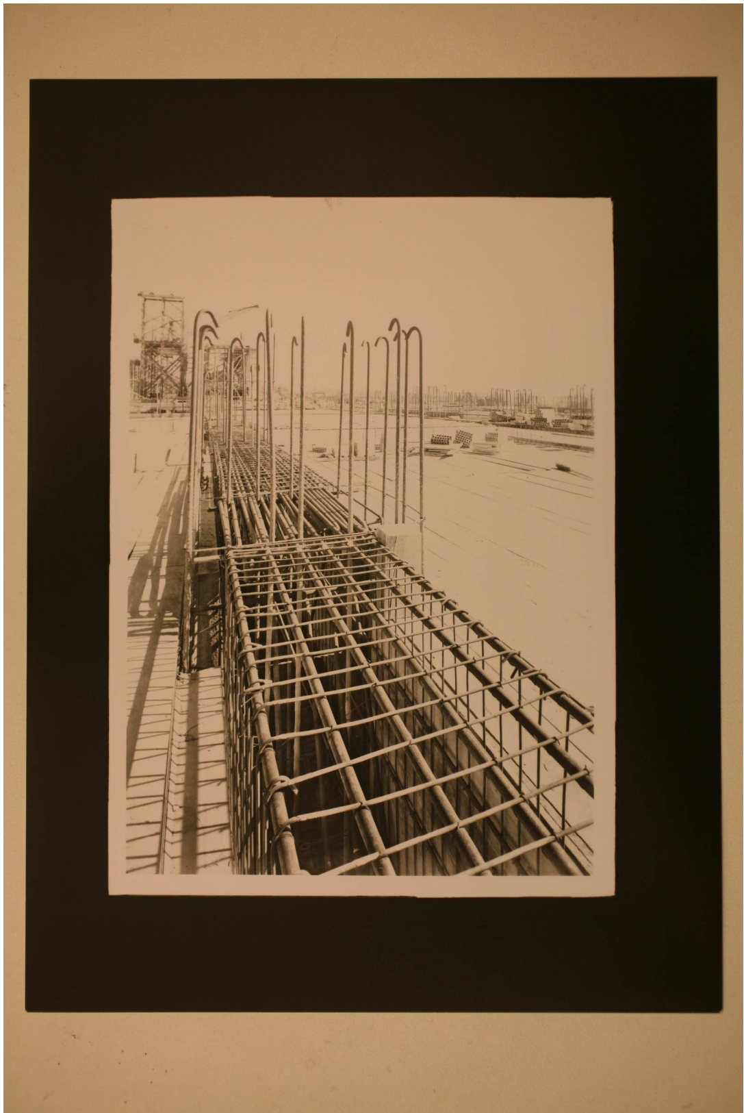
Fig. 99, Archivio Vasari, (Cantiere Palazzo della Farnesina), 1942 c.a., CSAC, sezione fotografia.
