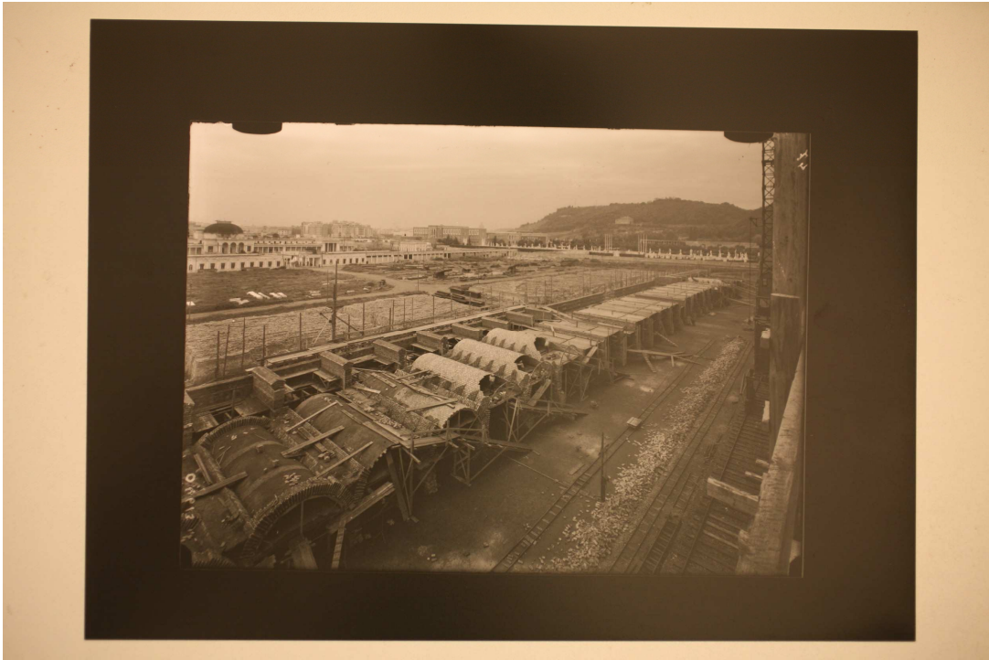
Fig. 95, Archivio Vasari, (Cantiere Palazzo della Farnesina), 1942 c.a., CSAC, sezione fotografia.
