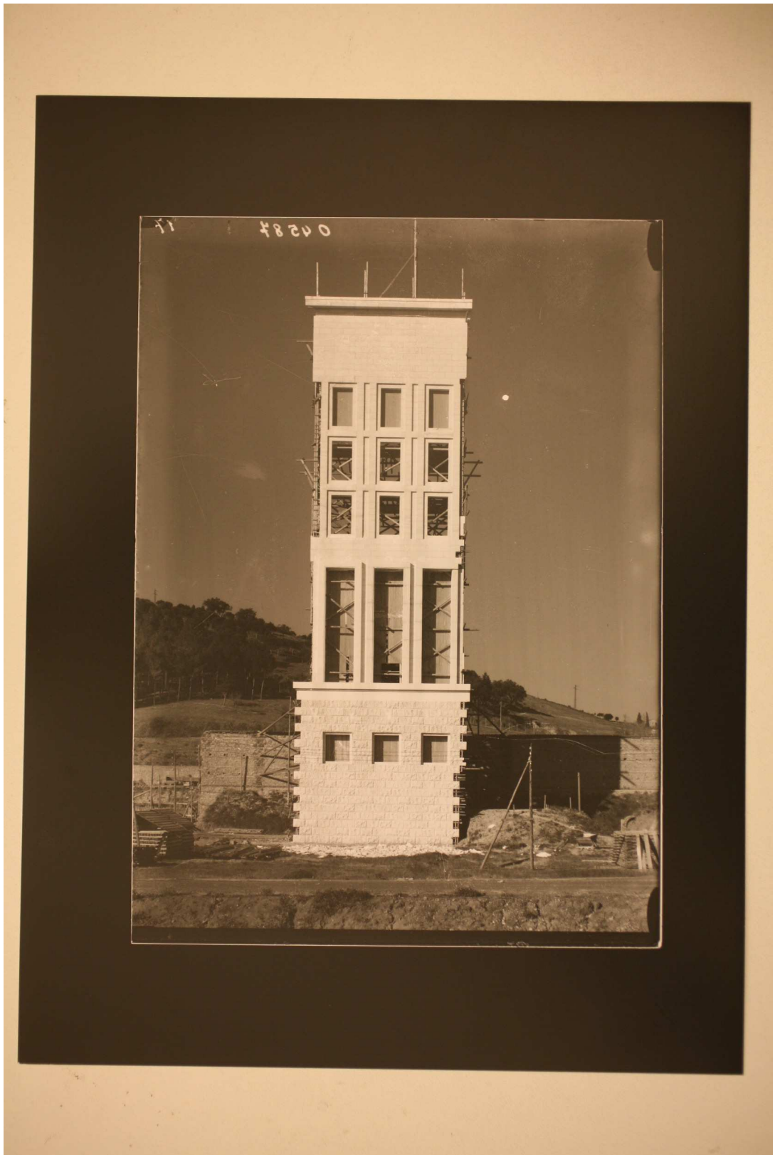
Fig. 107, Archivio Vasari, (Cantiere Palazzo della Farnesina), 1942 c.a., CSAC, sezione fotografia.
