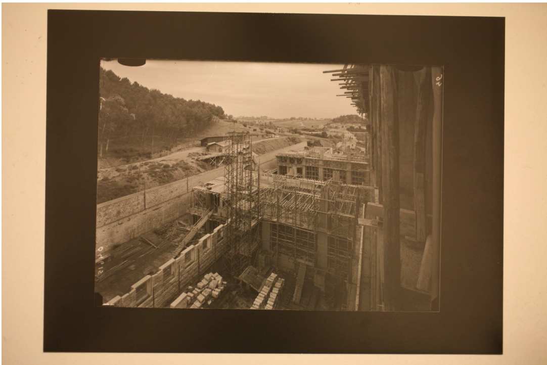
Fig. 96, Archivio Vasari, (Cantiere Palazzo della Farnesina), 1942 c.a., CSAC, sezione fotografia.
