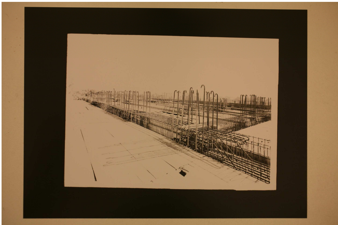
Fig. 98, Archivio Vasari, (Cantiere Palazzo della Farnesina), 1942 c.a., CSAC, sezione fotografia.
