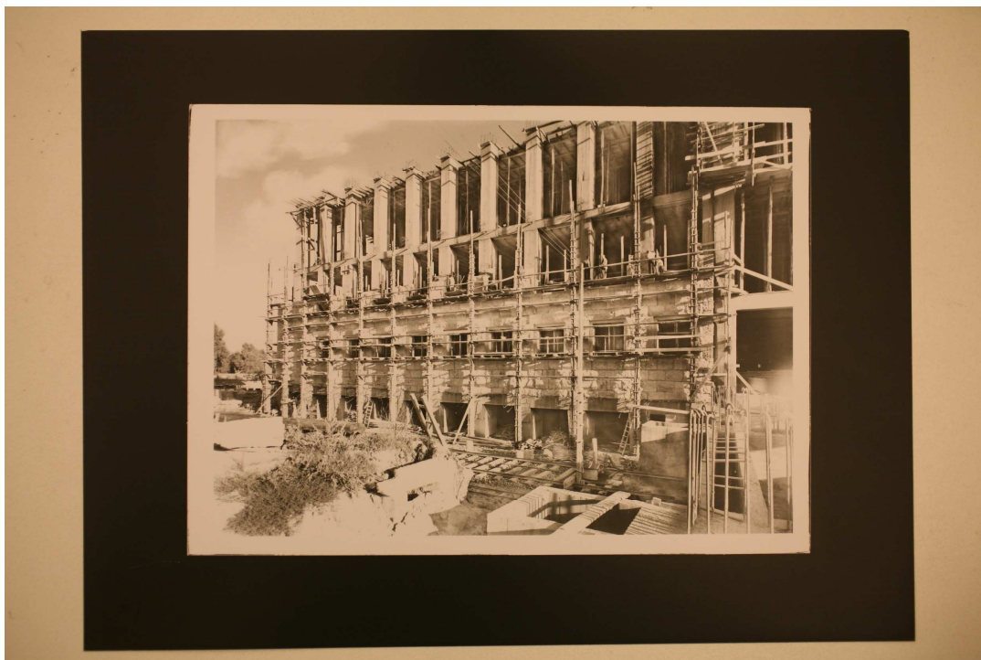
Fig. 103, Archivio Vasari, (Cantiere Palazzo della Farnesina), 1942 c.a., CSAC, sezione fotografia.
