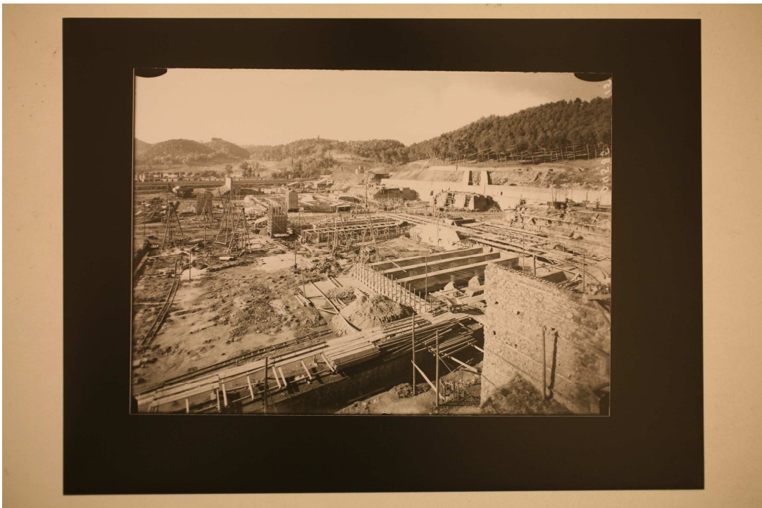
Fig. 90, Archivio Vasari, (Cantiere Palazzo della Farnesina), 1942 c.a., CSAC, sezione fotografia.
