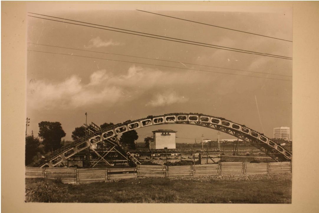
Fig. 55, Archivio Vasari, (Modulo di una copertura sottoposto a carichi), 1939, CSAC, sezione fotografia.
