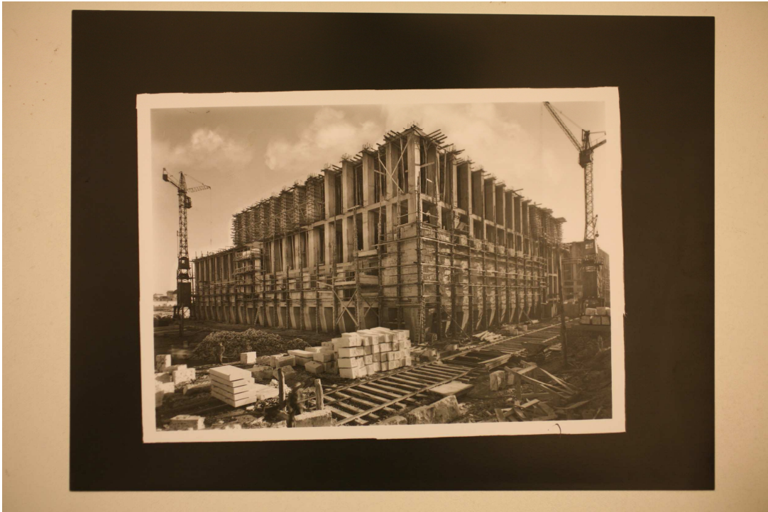
Fig. 83, Archivio Vasari, (Cantiere Palazzo della Farnesina), 1942 c.a., CSAC, sezione fotografia.
