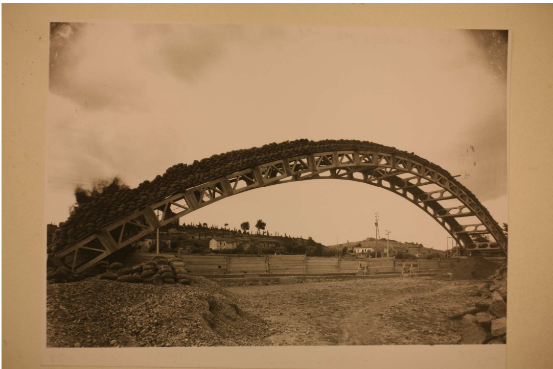
Fig. 56, Archivio Vasari, (Modulo di una copertura sottoposto a carichi), 1939, CSAC, sezione fotografia.
