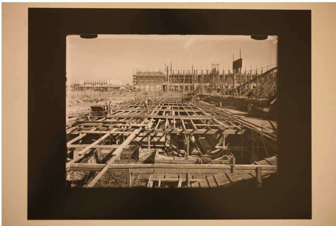
Fig. 91, Archivio Vasari, (Cantiere Palazzo della Farnesina), 1942 c.a., CSAC, sezione fotografia.
