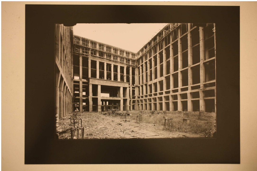
Fig. 87, Archivio Vasari, (Cantiere Palazzo della Farnesina), 1942 c.a., CSAC, sezione fotografia.
