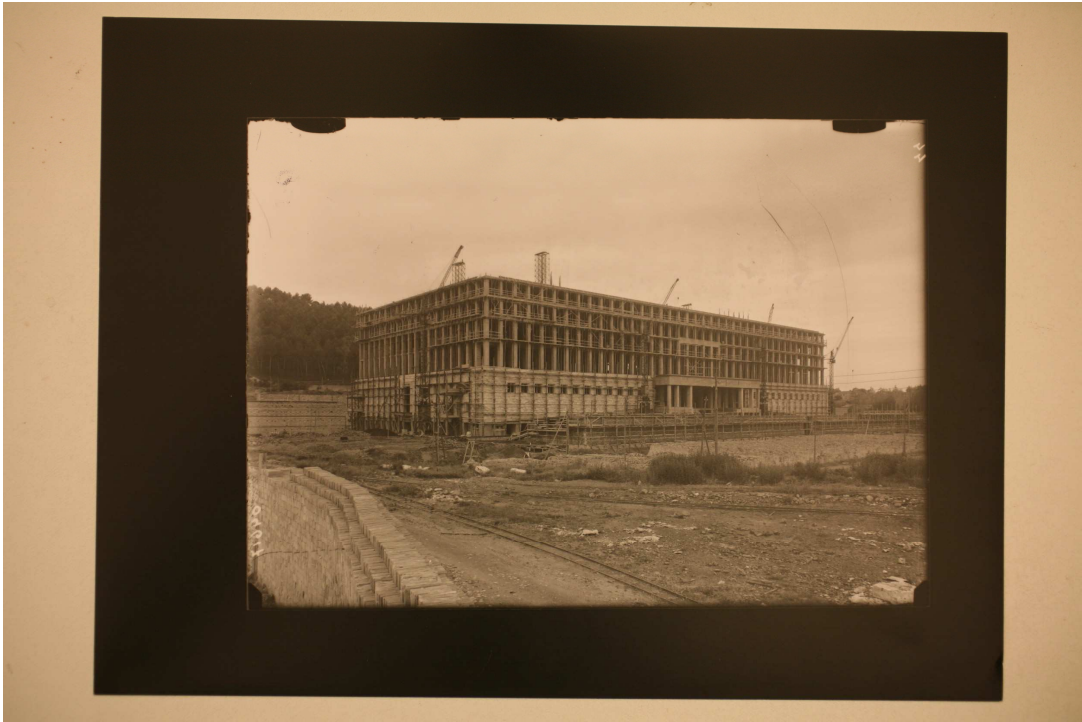
Fig. 85, Archivio Vasari, (Cantiere Palazzo della Farnesina), 1942 c.a., CSAC, sezione fotografia.
