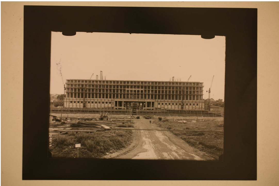
Fig. 86, Archivio Vasari, (Cantiere Palazzo della Farnesina), 1942 c.a., CSAC, sezione fotografia.
