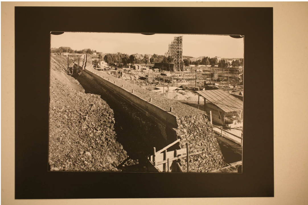
Fig. 94, Archivio Vasari, (Cantiere Palazzo della Farnesina), 1942 c.a., CSAC, sezione fotografia.
