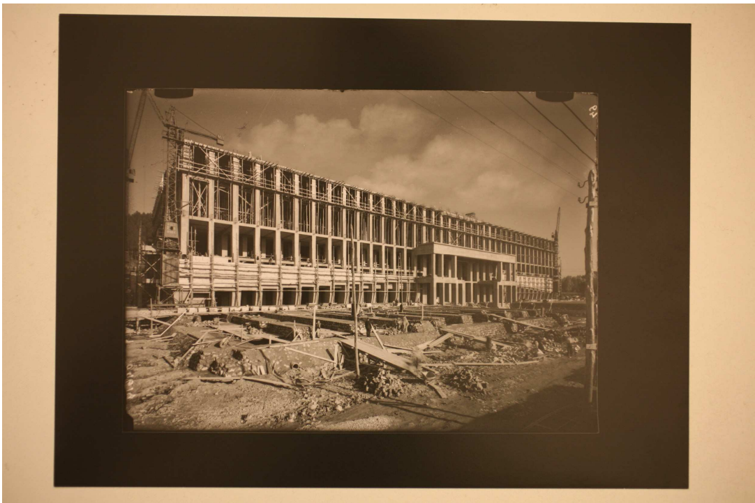
Fig. 84, Archivio Vasari, (Cantiere Palazzo della Farnesina), 1942 c.a., CSAC, sezione fotografia.
