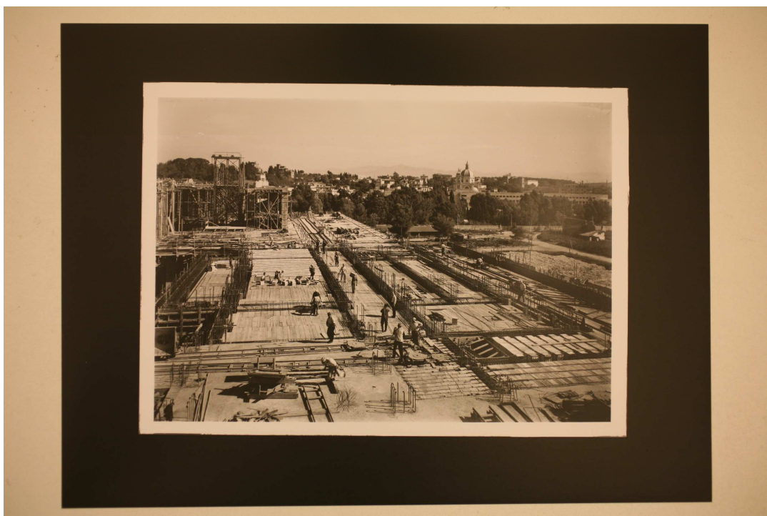
Fig. 92, Archivio Vasari, (Cantiere Palazzo della Farnesina), 1942 c.a., CSAC, sezione fotografia.
