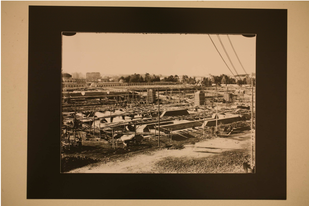
Fig. 89, Archivio Vasari, (Cantiere Palazzo della Farnesina), 1942 c.a., CSAC, sezione fotografia.
