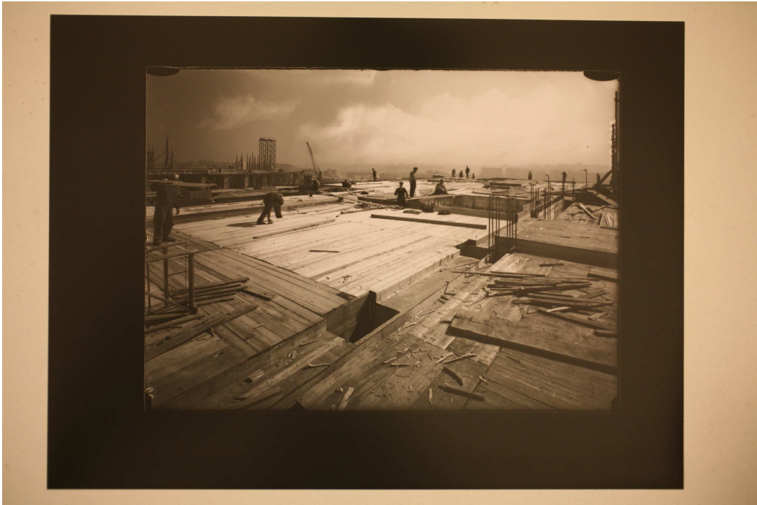
Fig. 93, Archivio Vasari, (Cantiere Palazzo della Farnesina), 1942 c.a., CSAC, sezione fotografia.
