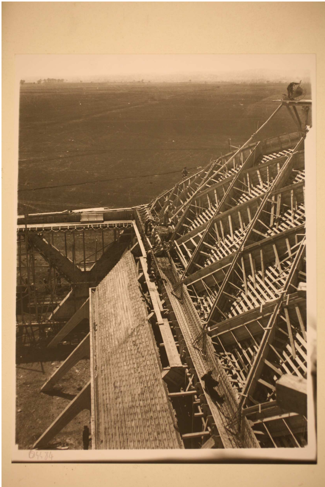
Fig. 12, Archivio Vasari, (Cantiere aviorimessa I tipo), 1935, CSAC, sezione fotografia.
