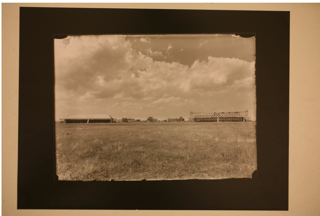
Fig. 21, Archivio Vasari, (Cantiere aviorimessa I tipo), 1935, CSAC, sezione fotografia.
