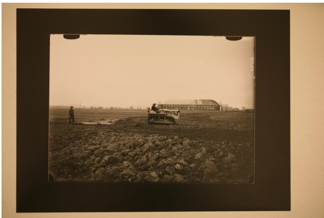
Fig. 20, Archivio Vasari, (Cantiere aviorimessa I tipo), 1935, CSAC, sezione fotografia.
