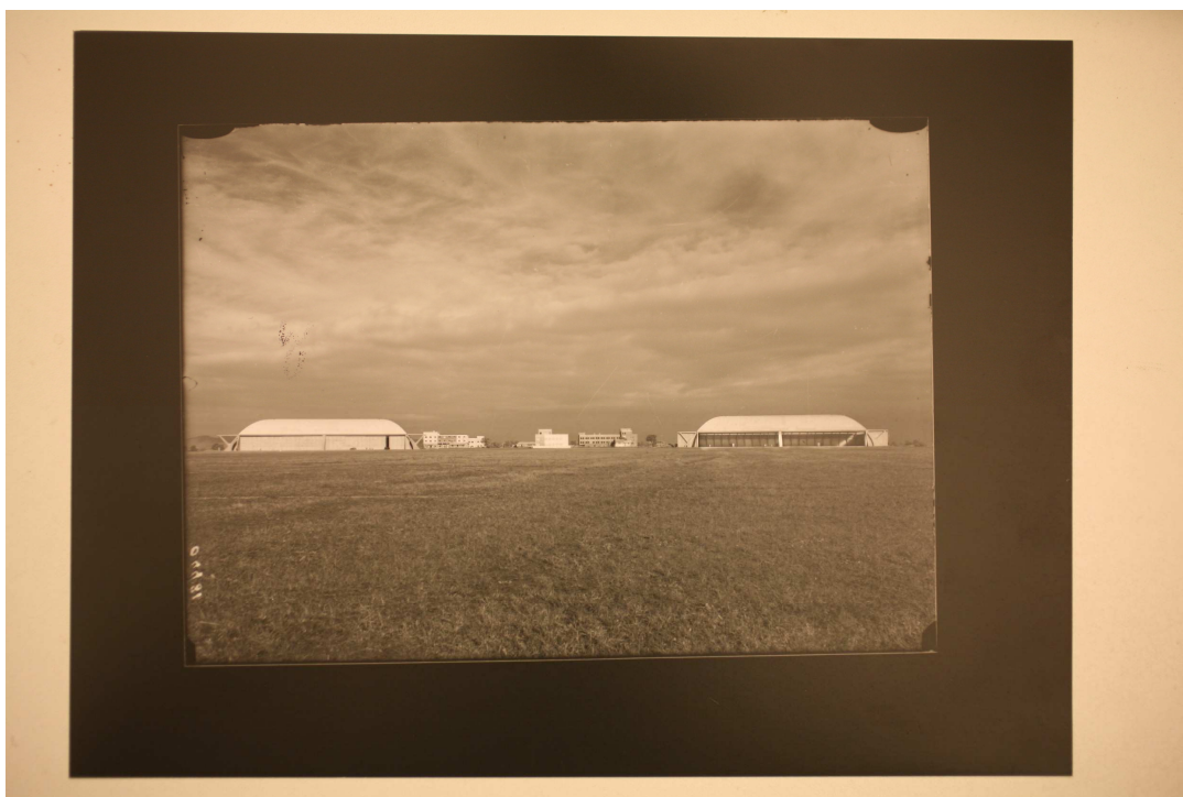
Fig. 22, Archivio Vasari, (Cantiere aviorimessa I tipo), 1935, CSAC, sezione fotografia.
