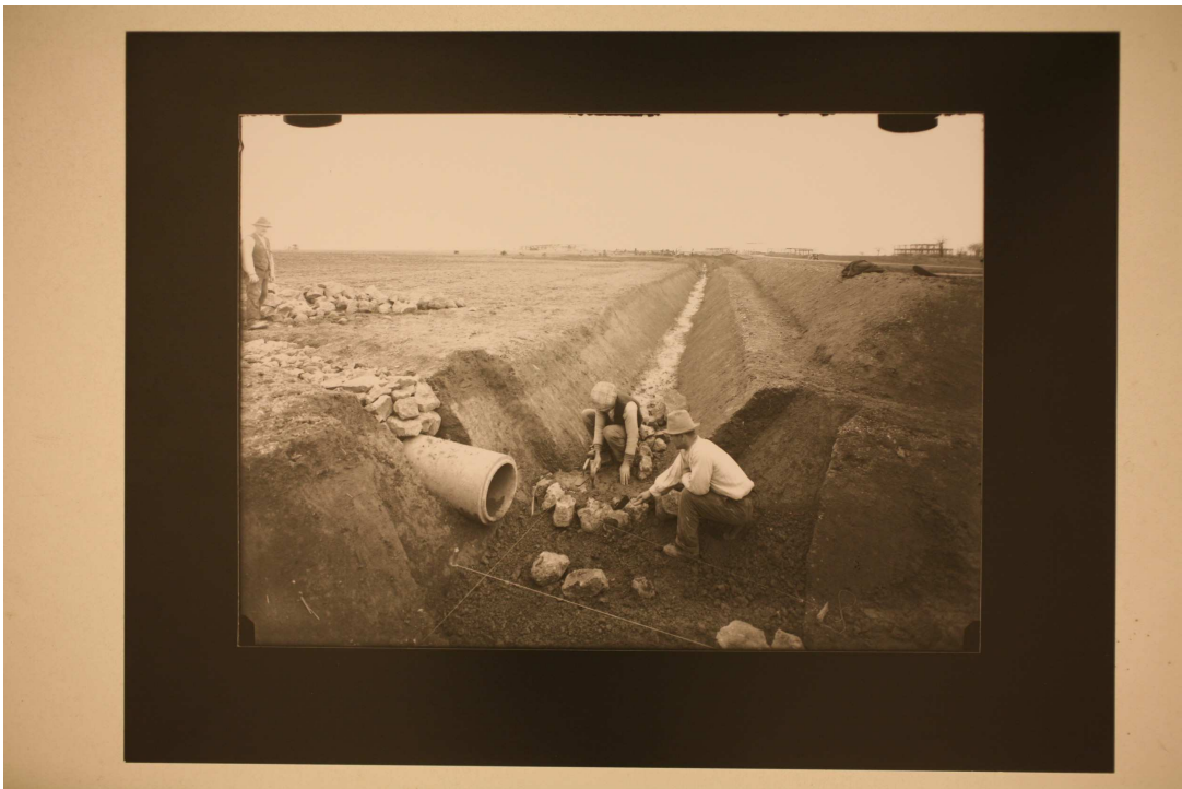
Fig. 13, Archivio Vasari, (Cantiere aviorimessa I tipo), 1935, CSAC, sezione fotografia.
