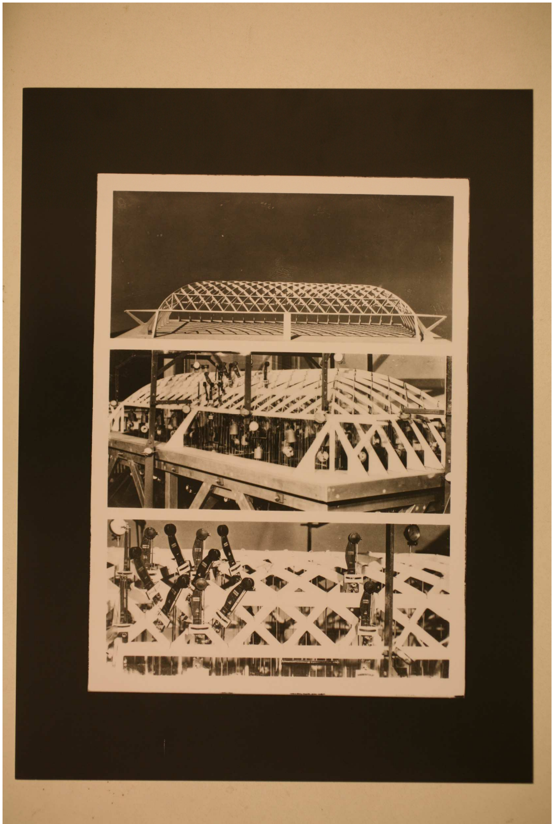
Fig. 8, Archivio Vasari, (Modello aviorimessa I tipo sottoposto a prove di carico), 1935, CSAC, sezione fotografia.
