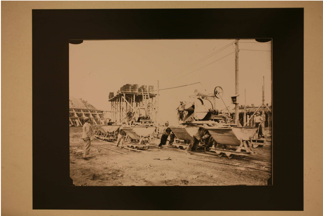
Fig. 12, Archivio Vasari, (Cantiere aviorimessa I tipo), 1935, CSAC, sezione fotografia.
