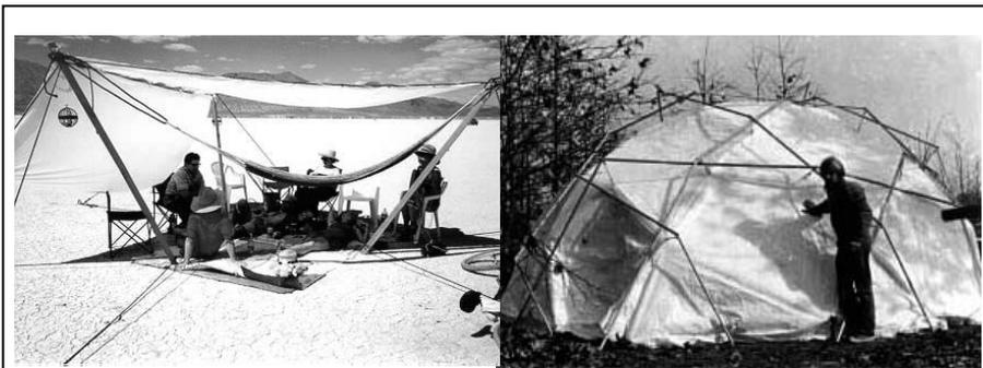
**Fig. 2.30: Clownland Enterprises, Inc. and Camp Elsewhere, Ltd., un riparo costituito da una unità tensegrity minima.**
