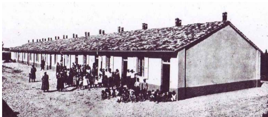
Fig 2.1.4 Vista dei padiglioni est dei fabbricati della Navetta - da G. Uccelli, I Fabbricati dell'Istituto Autonomo delle Case Popolari, in "Crisopoli", anno II, n. IV Luglio-Agosto 1933.
