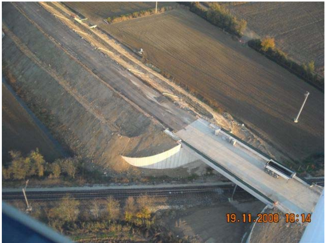
Fig.1.7- Rilevato stradale realizzato
