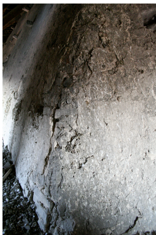
Figura 7.3.12. Le lesioni sugli spigoli visibili all'estradosso nel sottotetto
