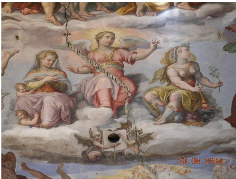
Figura 5.8 Esempio di propagazione della frattura nella spinapesce 227
