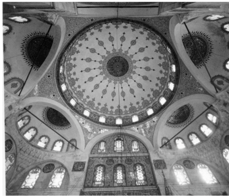
Figura 3.3.4. La cupola della moschea di Solimano il Magnifico, in cui le catene inserite da Sinan sono visibili.
