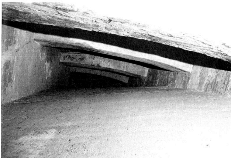
Figura 5.1.4. La catena lignea visibile tra il primo e secondo camminamento xxx
