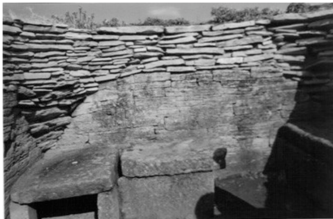
Fig. 2.3.6. La disposizione interna delle pietre che formano la cupola della Tomba dei Carri a Populonia.
