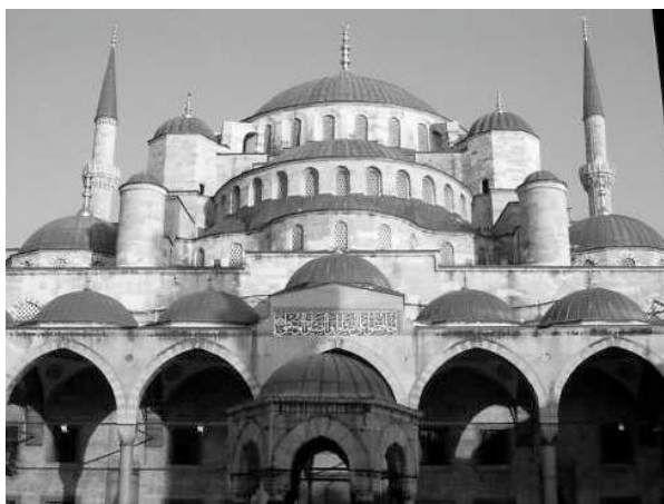
Figura 3.3.6. Il sistema di semicupole usato nella moschea Blu .
